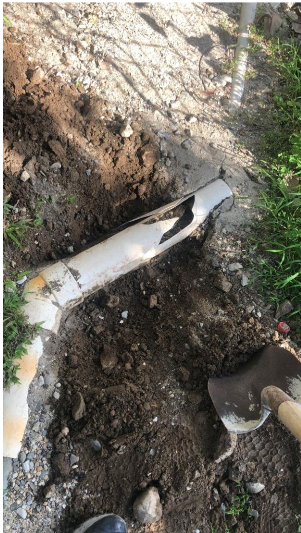
Reparación de tubería en mal estado en plantel donde funcionan las Oficinas de Obras Menores y Mantenimiento Municipal.
