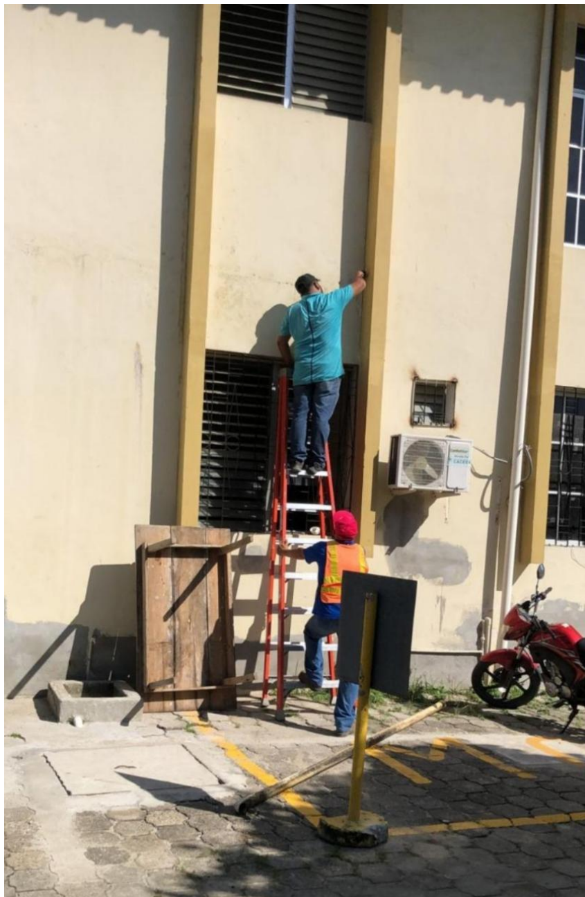
1Reparación de Tubería de pileta en baño de caballeros en la segunda planta del Palacio Municipal
