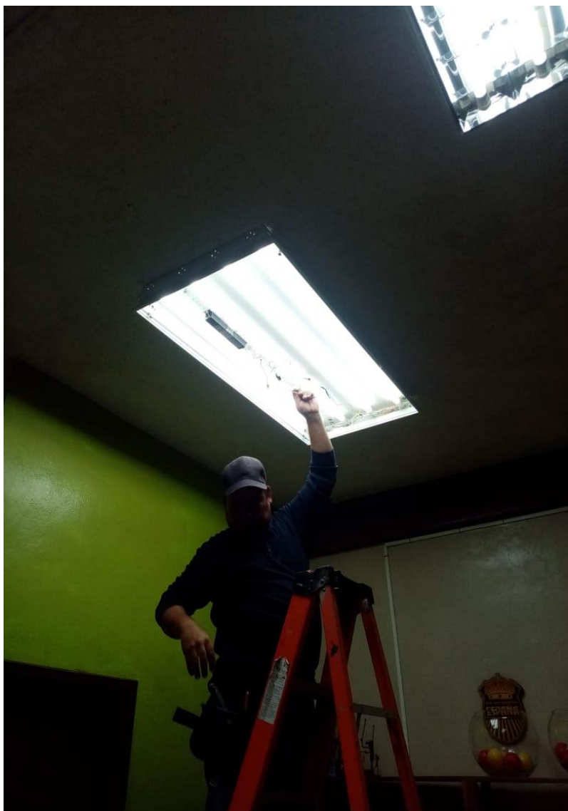
Reparación de la iluminación en Gerencia de Planificación y Desarrollo.
