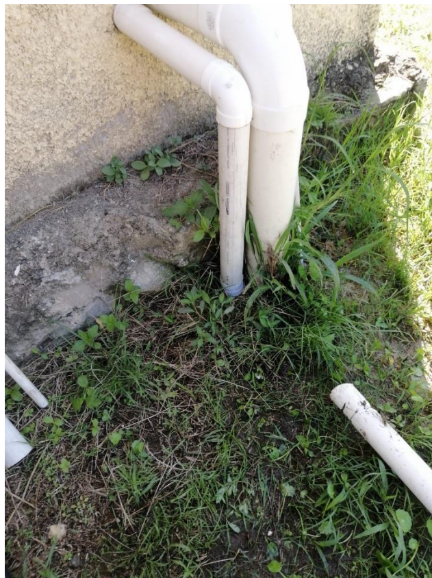
Reparación de Tuberías en Oficinas de Policía Comunitaria en Barrio Pueblo Nuevo.
