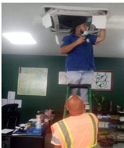
Limpieza de Aire Acondicionado en el Departamento de Alcaldía
