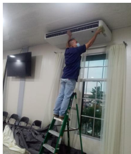
Revisión de los aires acondicionados del Salón Consistorial en el Palacio Municipal
