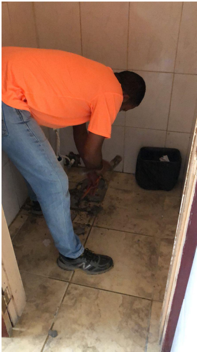
Reparación de Inodoro obstruido, haciendo desmontaje de éste en baño de Caballeros de la segunda planta del Palacio Municipal.
