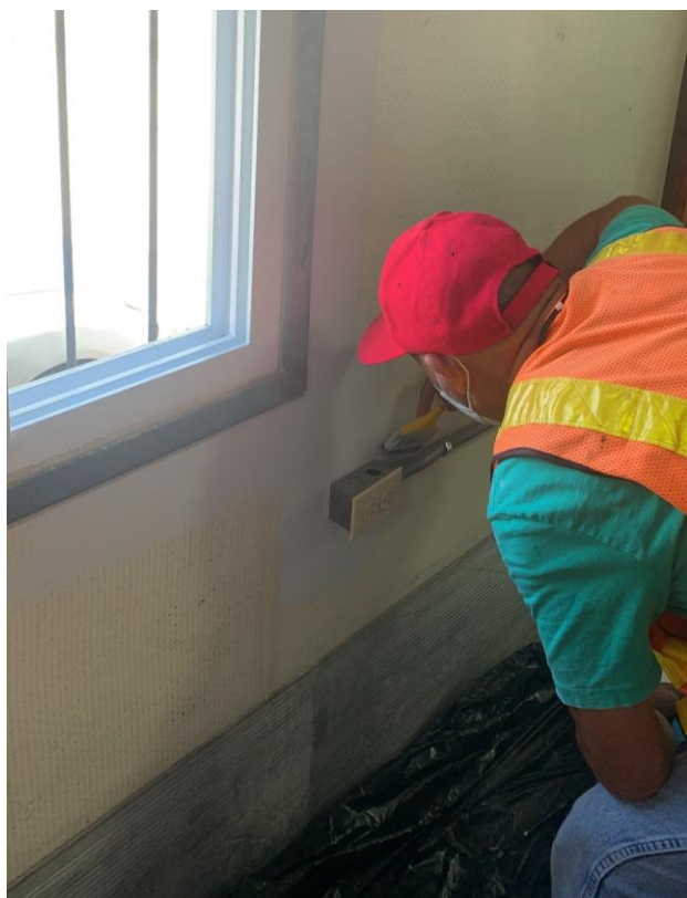
Colocando sellador en paredes de las nuevas oficinas del Peaje Municipal
