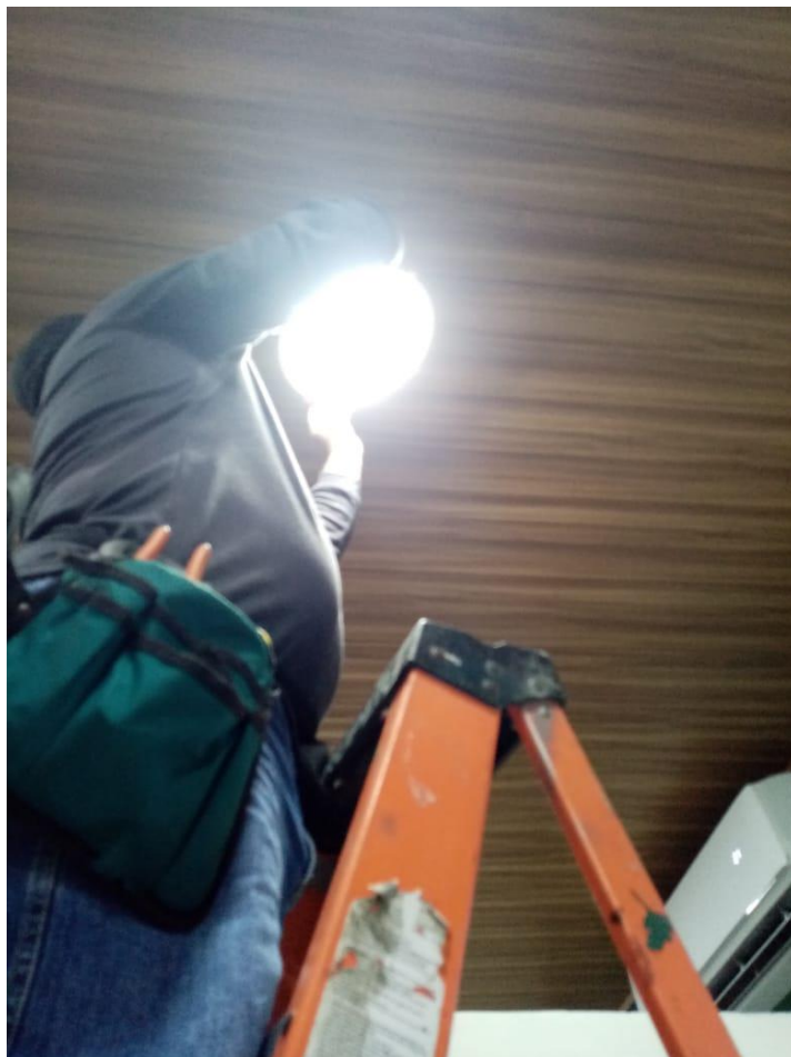
Reparación de lámparas tipo spot en oficinas de Talento Humano
