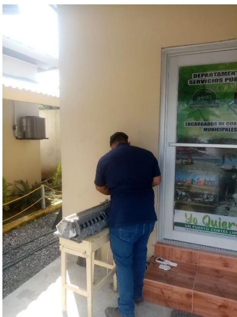
Limpieza de Aire Acondicionado en el Departamento de Servicios Públicos
