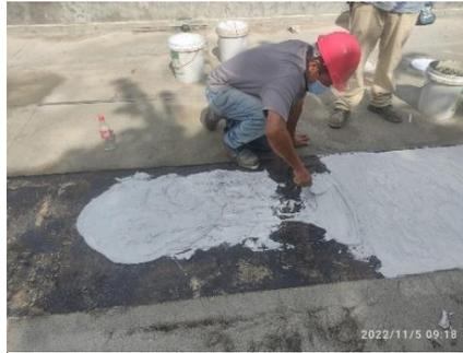
**Colocación de Epoxy Jelly como nivelante e impermeabilizante en losa de Diesel House.**
