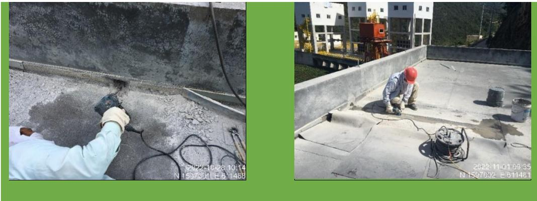
**Trabajos de perforación en pretil de Diesel House y desbaste en losa superior.**
