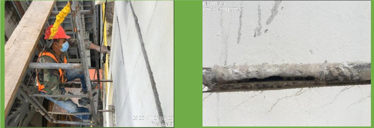
Trabajos de desbaste con pulidora entre el marco rígido y paredes de bloque en Cuarto de Bomba No.1.
