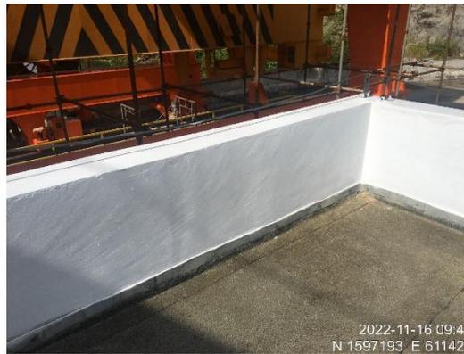
**Estructura de Acceso a Cubo de Gradas de Galería de Presa con pintura impermeabilizante elastomérico.**
