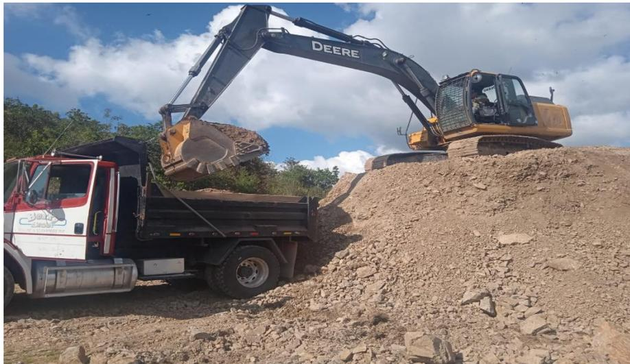
Máquina Excavadora 210-G en corte y carga de material selecto en Aldea El Llanon para balastar el Barrio Las Brisas
