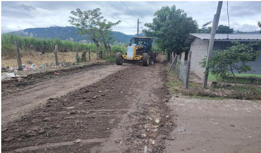
Maquinaria municipal en trabajos de escarificado, conformación, cuneteo y vibrado de calle en Colonia Nueva Esperanza
