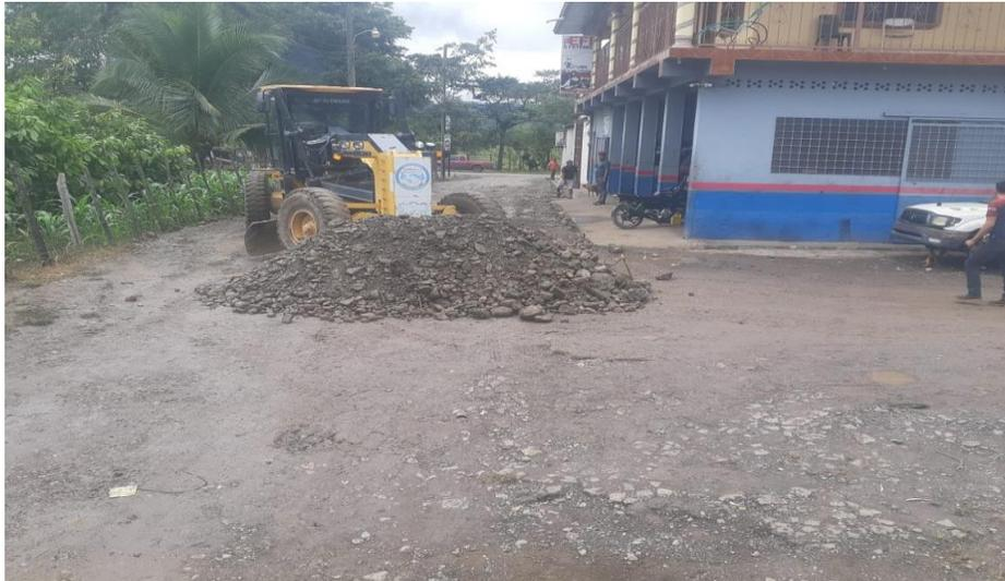
Se aprecia la maquina Motoniveladora 670-G y Vibro compactador en trabajos de escarificado, conformación, cuneteo y vibrado de calle en Colonia Miravalle
