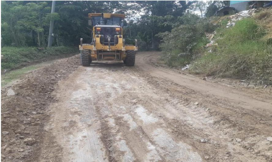
Trabajos de escarificado, conformación, cuneteo y vibrado de desvío que conduce hacia Aldea Nueva Arcadia
