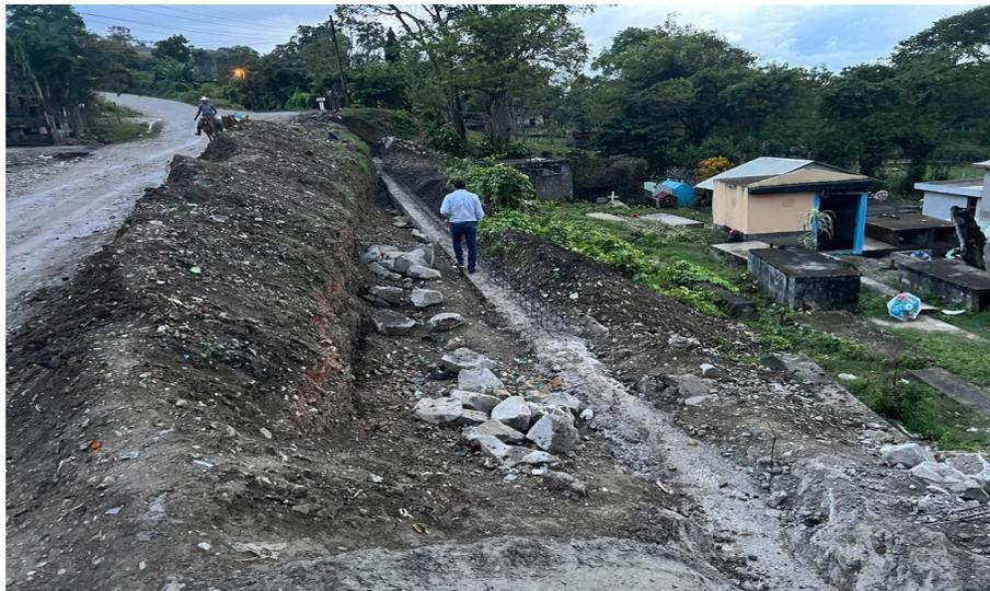
Se aprecia la construcción de la cimentación de mampostería en el proyecto Construcción de muro para cementerio Aldea Chalmeca
