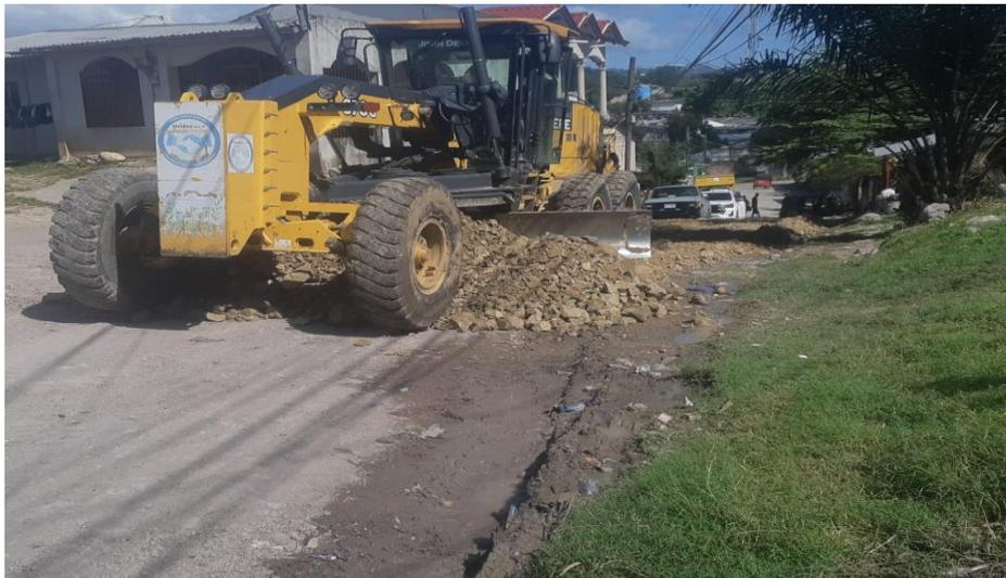
Trabajos de escarificado, conformación, cuneteo y vibrado de calles en Barrio Las Brisas de la ciudad de La Entrada
