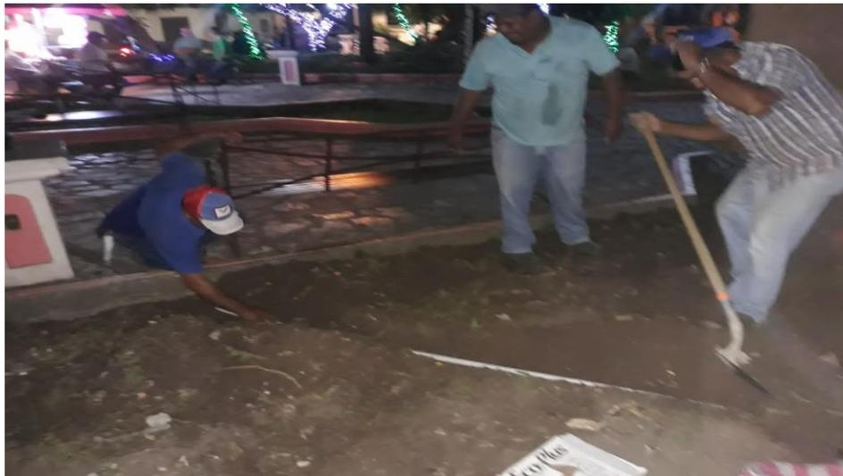
Se aprecia el personal del Departamento de Obras Públicas en trabajos de instalación de tubería para construcción de sistema eléctrico en el proyecto Mantenimiento del Parque Central Municipal.
