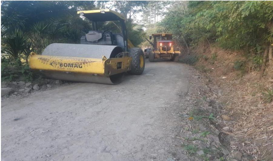
Maquinaria municipal en trabajos de escarificado, conformación, cuneteo y vibrado de calles en Barrio El Cielito
