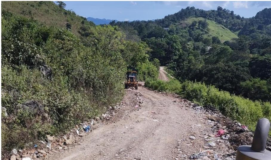
Maquinaria municipal en trabajos de escarificado, conformación, cuneteo y vibrado de calle que conduce del Barrio Las Brisas hacia el Relleno Sanitario Barrio Bella Vista 2
