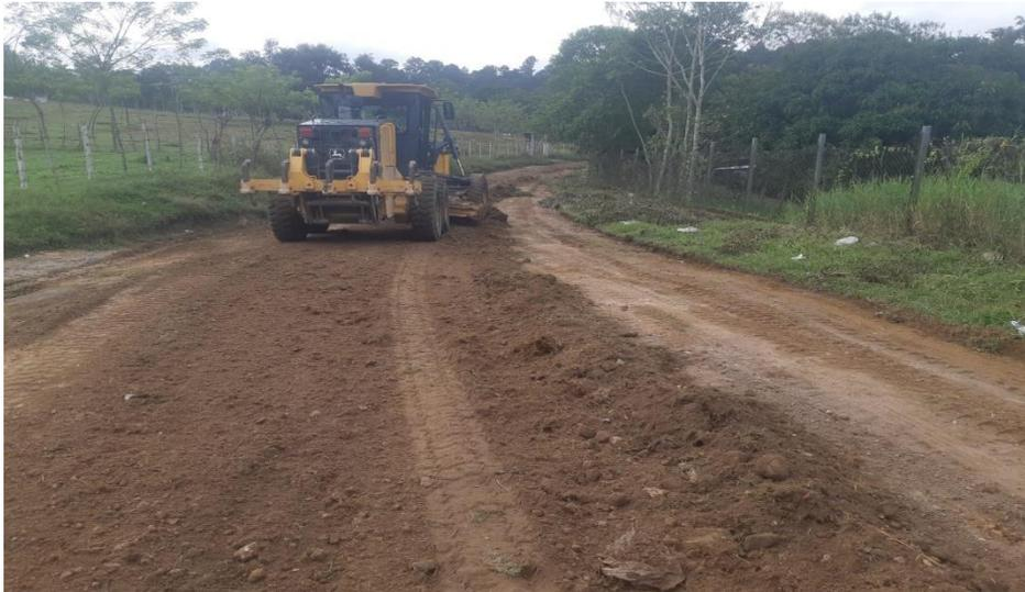
Maquina municipal Vibro compactador y Motoniveladora 670-G en trabajos de escarificado, conformación, cuneteo y vibrado de calle que conduce de la Aldea La Unión hacia Caserío El Tablón
