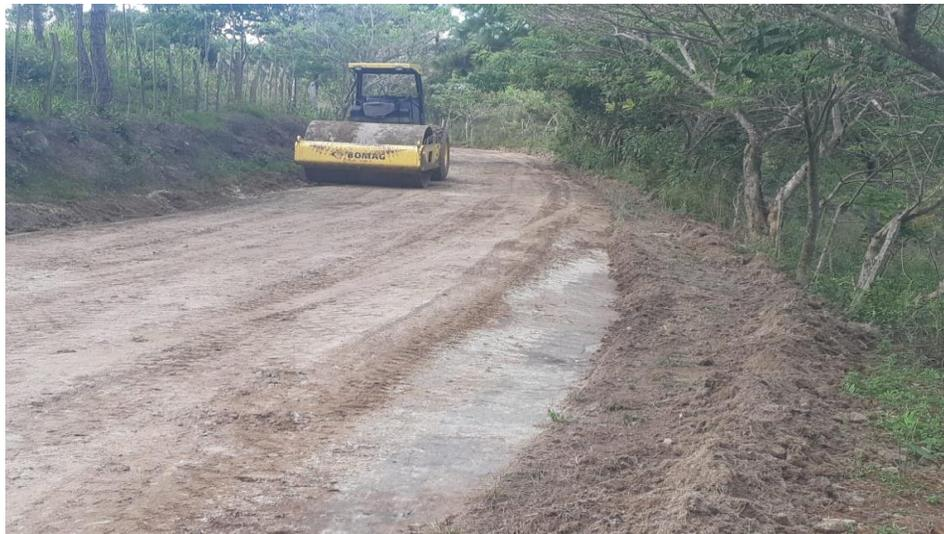
Se visualiza la maquinaria municipal en trabajos de escarificado, conformación, cuneteo y vibrado de calle que conduce hacia la Aldea El Ocotillo
