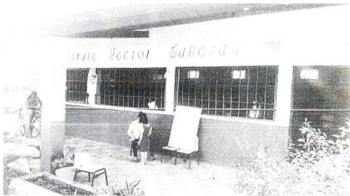
1.- Actual aula escolar construida.
