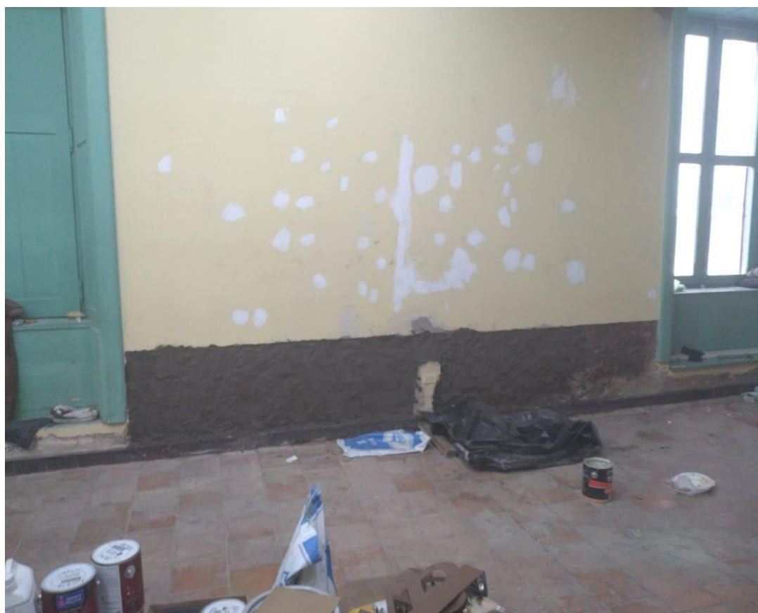
Curación de pared con hongos en la BINAH, sellado y relleno de la misma.
