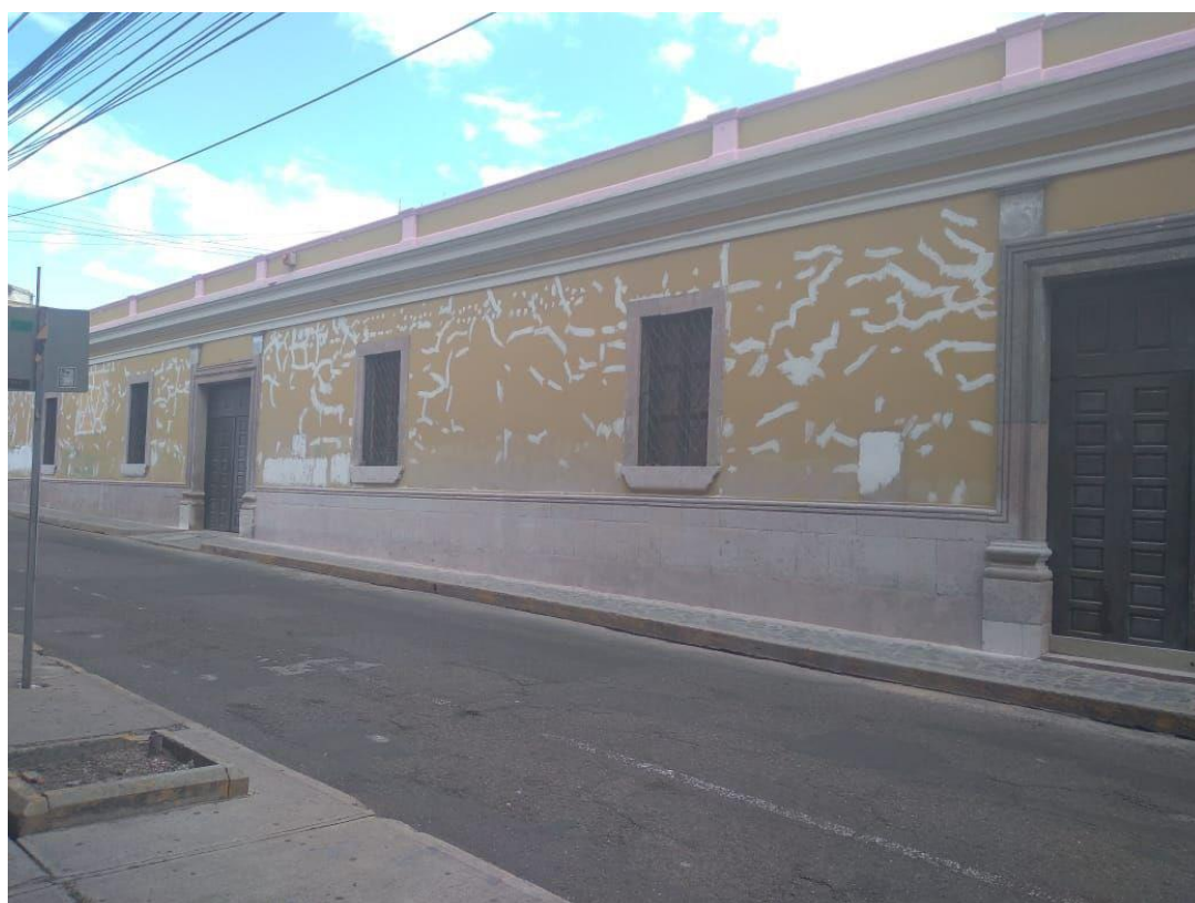
Lijado, raspado y pintada de la fachada de la BINAH
