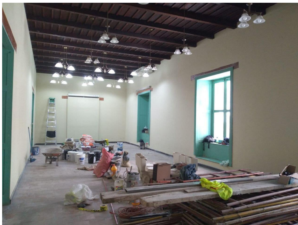
Preparación de salón de usos múltiples de la BINAH para restauración de paredes, material de trabajo para las respectivas reparaciones
