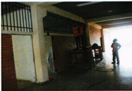
Desmontajes de Barandales Metálicos
