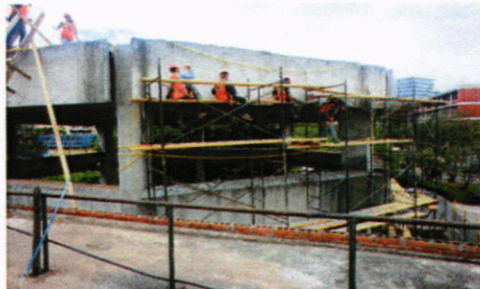
Demolición de Parasoles de Concreto
