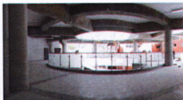
Modulo D: Pasamanos de vidrio templado en pasillos
