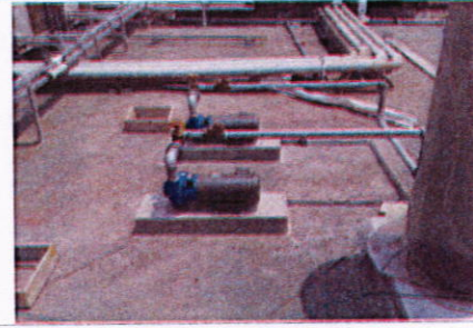
Instalación de bombas en Azotea.
