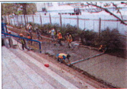
Fundición de acera en lado oeste.
