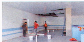
Módulo B: Instalacion de piso de vinil en area clinica odontologia.
