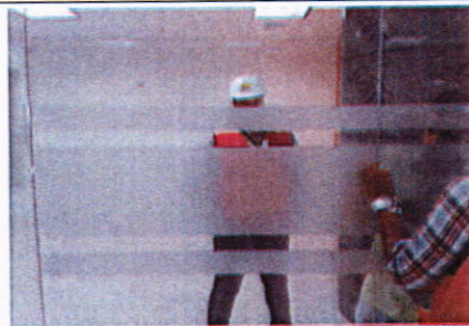
Instalación de sticker en paredes de vidrio.
