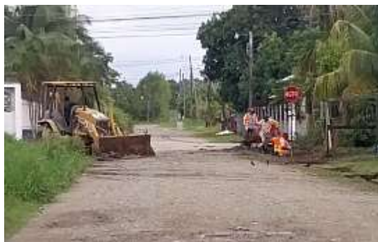
Apoyo al Depto. De Servicios Públicos en la Limpieza de canales pluviales de Bo. San Ramón, Sector Península Oeste 1.
