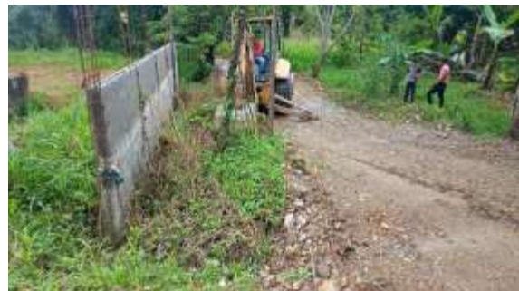
Apoyo al Depto. De Mantenimiento Vial en la limpieza de canales pluviales naturales De Chameleconcito, Sector Chameleconcito
