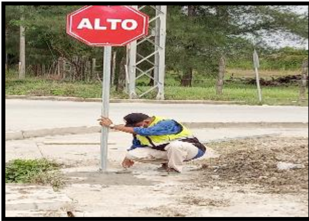
Instalación de señal de alto B0. Suyapa 9 avenida 9 calle este
