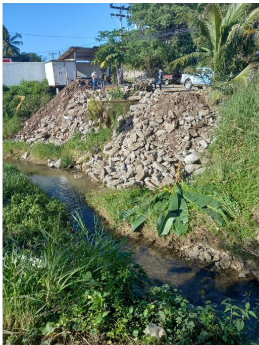
Atención a denuncia en Barrio Medina Por afectación a la quebrada.
