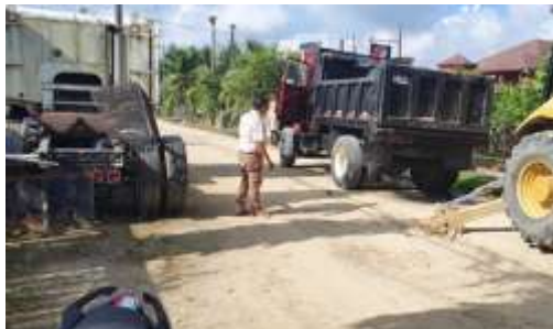
Apoyo al Departamento de Servicios Públicos en la Limpieza de canales pluviales de Guanacastales, Sector Ramal de Lima.
