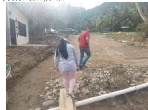
Inspección del proyecto construcción de pavimentada de la Col. Nueva Campana, Sector Campana.
