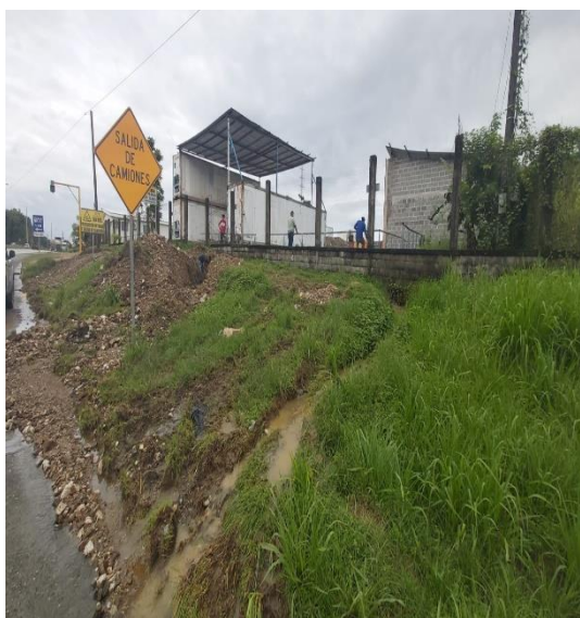
Segunda orden de paro por construcción de Oficinas Honduras Logistic Shopping .
