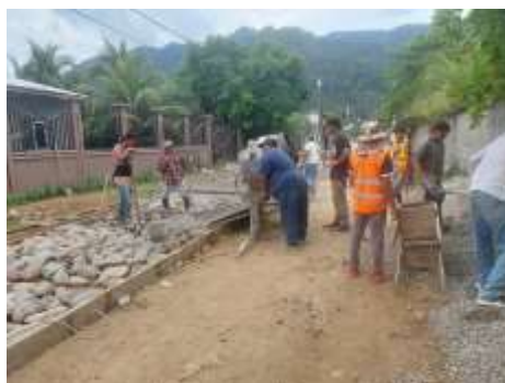
Inspección de construcción de la II Etapa De calle pavimentada de la Col. La Gran Villa, Sector Campana.
