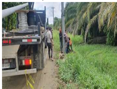
Inspección del proyecto mejoramiento del sistema eléctrico de la Comunidad de Guanacastales, Sector Ramal de Lima.
