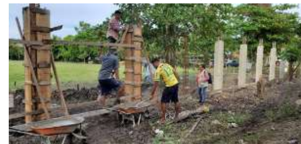
Inspección del Proyecto construcción de gradería De la Cancha de futbol de Cedros, Sector Calan.
