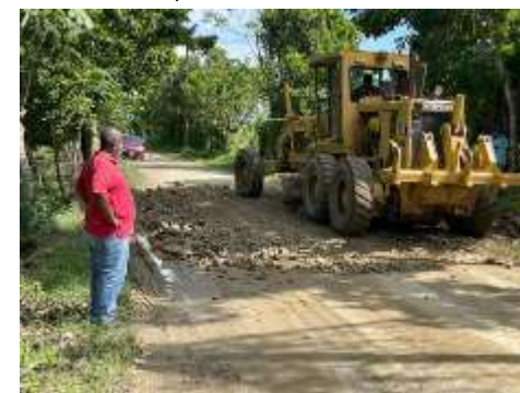
Apoyo al Depto. De Mantenimiento Vial en la reparación de carretera de Brisas de Chamelecón, Sector Garífuna.
