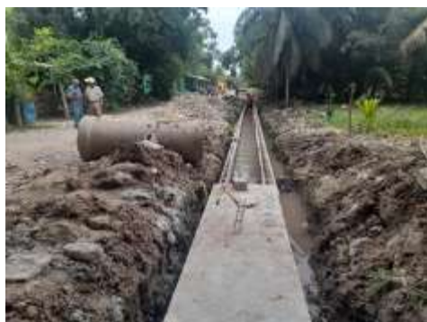
Inspección de avances de construcción de Canales Pluviales en la Comunidad de El Mango, Sector Tapón de los Oros.
