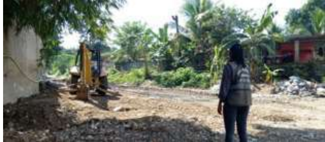
Apoyo al Depto. De Servicios Públicos en el dragado de quebrada de Gracias a Dios, Sector Puente Alto.
