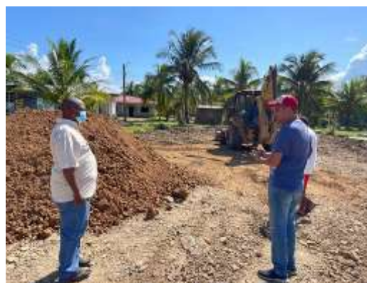
Apoyo al Depto. De Mantenimiento Vial en la entrega de material de relleno del predio donde se construirá el Centro Social de Bajamar, Sector Garífuna.
