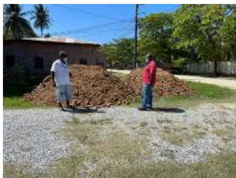
Apoyo al Depto. De Mantenimiento Vial en La entrega de 2 viajes de material de relleno Al C.E.B. Miguel Paz Barahona de Travesía, Sector Garífuna.
