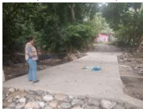
Inspección de construcción de vado de la Col. Campo Verde, Sector Campana.
