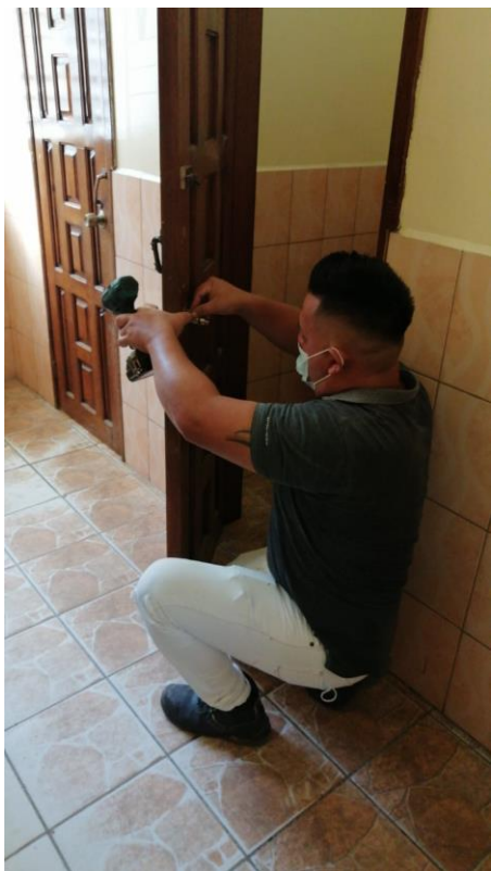
Instalación de llavín
