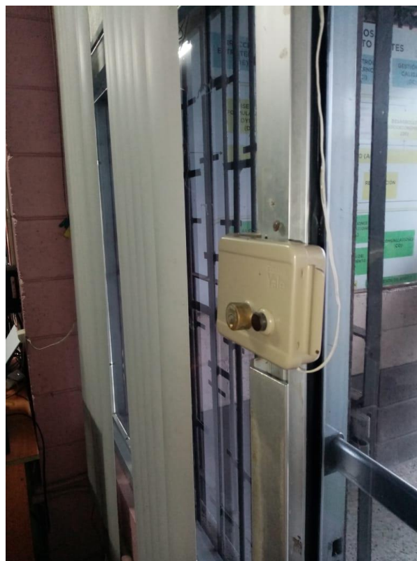
Reparación de Timbre Eléctrico en el Departamento de Investigación y Formulación de Proyectos.
