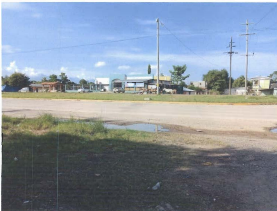
Vista desde la Subestación Santa Martha, la flecha señala las viviendas de la Col.15 de Septiembre comunidad ubicada en Dirección Norte de la subestación.
