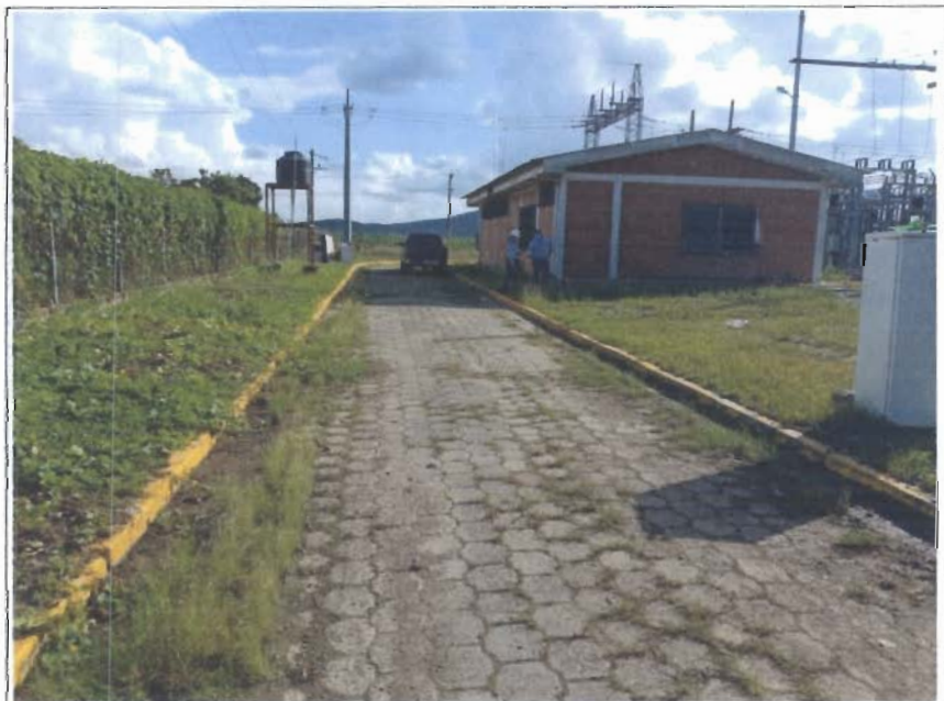
Calle de acceso a la Subestación
