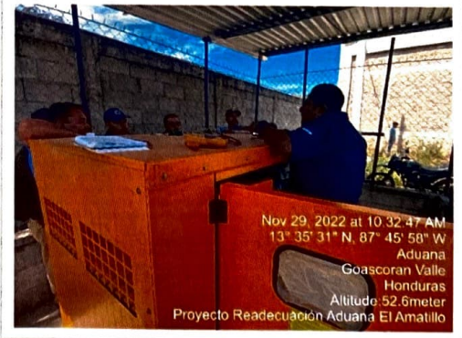
Capacitación sobre el Funcionamiento y uso correcto del Generador eléctrico
