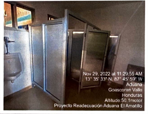
Área de baños
