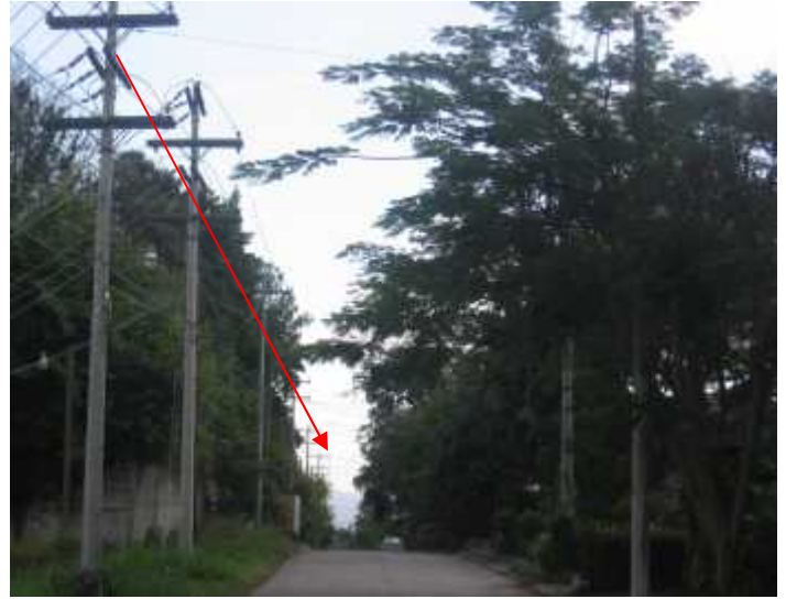
Ruta de línea de distribución de 13.8 Kv, que sale de la subestación Bella Vista, Residencial Río de Piedra
