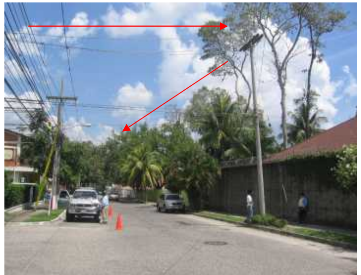
A la derecha se observa uno de los postes que serán sustituidos por los del nuevo diseño, aquí se colocara el poste no. 10
