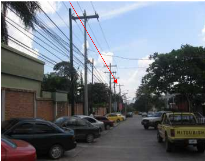
A la Izquierda se observa el parqueo del Club Hondureño Árabe y la línea de distribución de 13.8 Kv donde irán los nuevos postes
