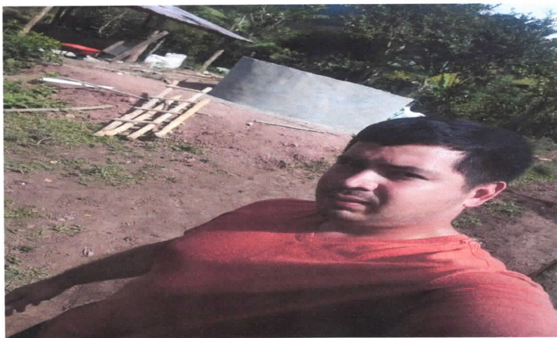
Monitoreo de construcción de tanques de ferrocemento a beneficiario Juan Rodriguez de la comunidad de Gualan
