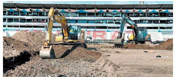
Las máquinas continúan sacando promontorios de tierra porque según aseguran los expertos no es buena para la grama híbrida que se instalará.
