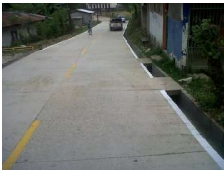
Construcción de Empedrado, canales pluviales y cruce de calle en la comunidad del Chile
