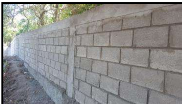
3.7 Construcción de Cerco Perimetral y Canal de Bloque en Centro de Salud (Priorizado), Aldea Kele-Kele, Sector Ramal de Lima: con un Monto de L. 799,723.50
