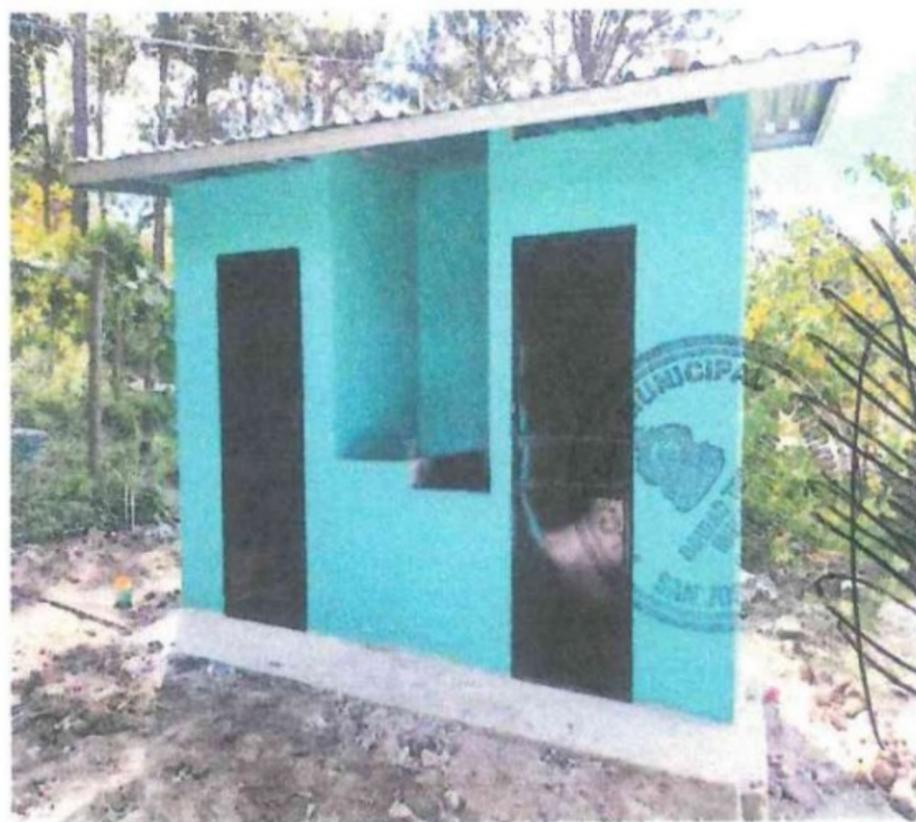
**MÓDULOS SANITARIOS CONSTRUIDOS EN UN 100% REVESTIDO DE CONCRETO, PULIDO, PINTADO, TECHO CON CANALETA Y ALUZINC METÁLICO**
