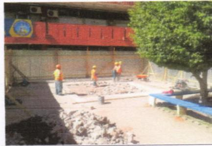
Demolición de firme de piso en sitio del cubo del elevador, Edificio A2
