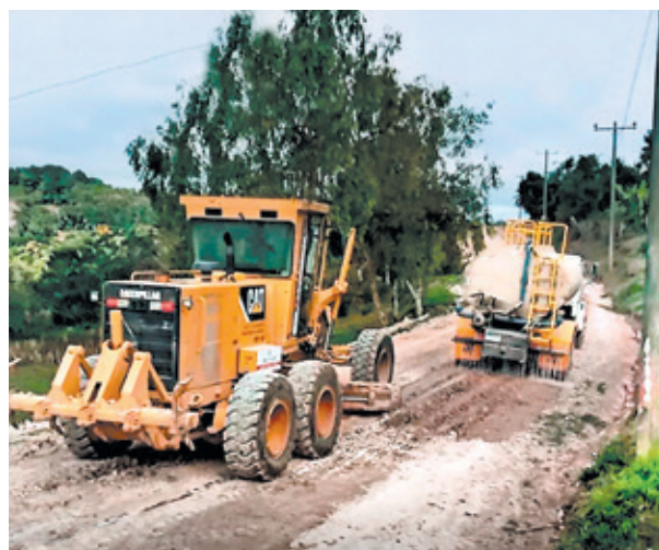
Avanza el acondicionamiento en carretera, limpieza y cambio de alcantarillas en más de 20 kilómetros en el departamento de Intibucá.
