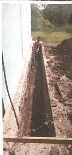
EXCAVACIÓN MATERIAL TIPO I (MATERIAL COMÚN)
