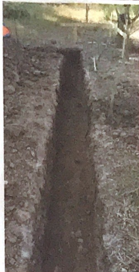
EXCAVACIÓN MATERIAL TIPO I (MATERIAL COMÚN)
