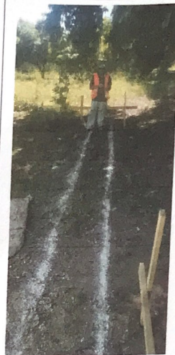
INICIO DEL PROYECTO CON ACTIVIDAD DE TRAZADO Y MARCADO
