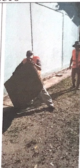
REMOCIÓN DE CAPA VEGETAL Y TRABAJOS PRELIMINARES
