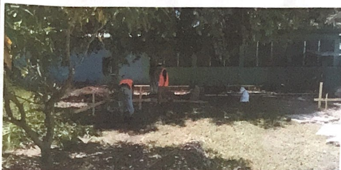
INICIO DEL PROYECTO CON ACTIVIDAD DE TRAZADO Y MARCADO
