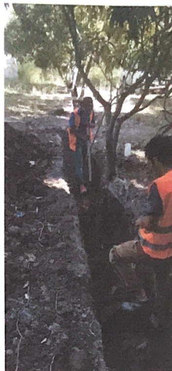
EXCAVACIÓN MATERIAL TIPO I (MATERIAL COMÚN)
