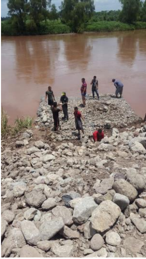
Construcción de Espigones Meroa Rio
