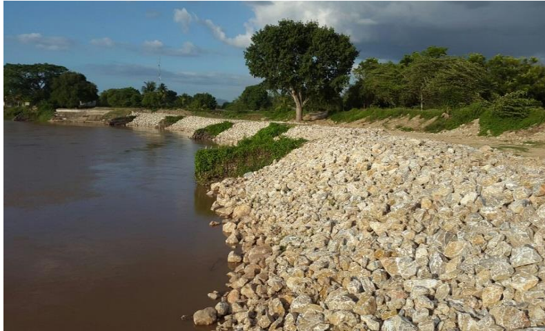
Escollera de Piedra en Aldea La 45 en el Municipio de El Progreso Yoro
