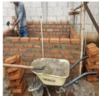
Construcción de pila para el almacenamiento de agua potable.
