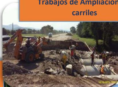
**Excavación estructural para construir el estribo No. 1 del nuevo puente Santa Rita**
