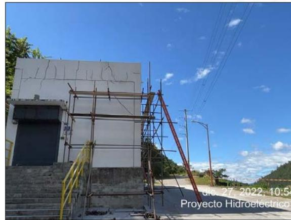
Trabajos de desbaste de paredes externas en zonas fisuradas.
