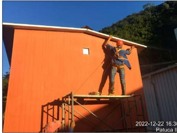
Pintado de ángulos en estructura de techo en Grúa de Desfogue.
