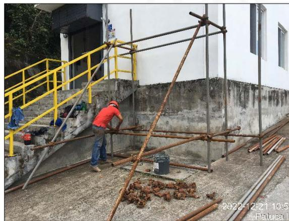
Trabajos de armado de andamios de seguridad para trabajos en altura en Diesel House.
