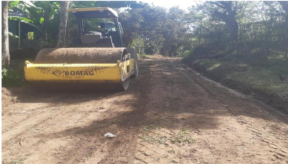
Maquina Motoniveladora 670-G y Vibro compactador en trabajos de escarificado, conformación, cuneteo y vibrado de calle que conduce de la aldea El Ocotillo hacia la aldea El Tablón
