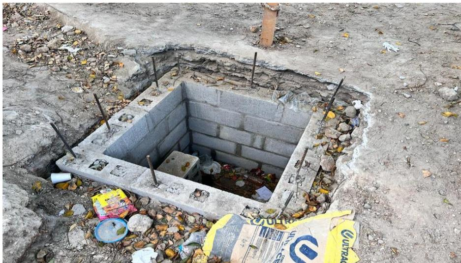
Trabajos en la construcción de cajas de registro y demolición de losa para realizar conexión de las cajas hacia un pozo colector de aguas residuales del proyecto Construcción de estacionamiento y mejoras a mercado artesanal ubicado en barrio El Triángulo, La Entrada Copán.
