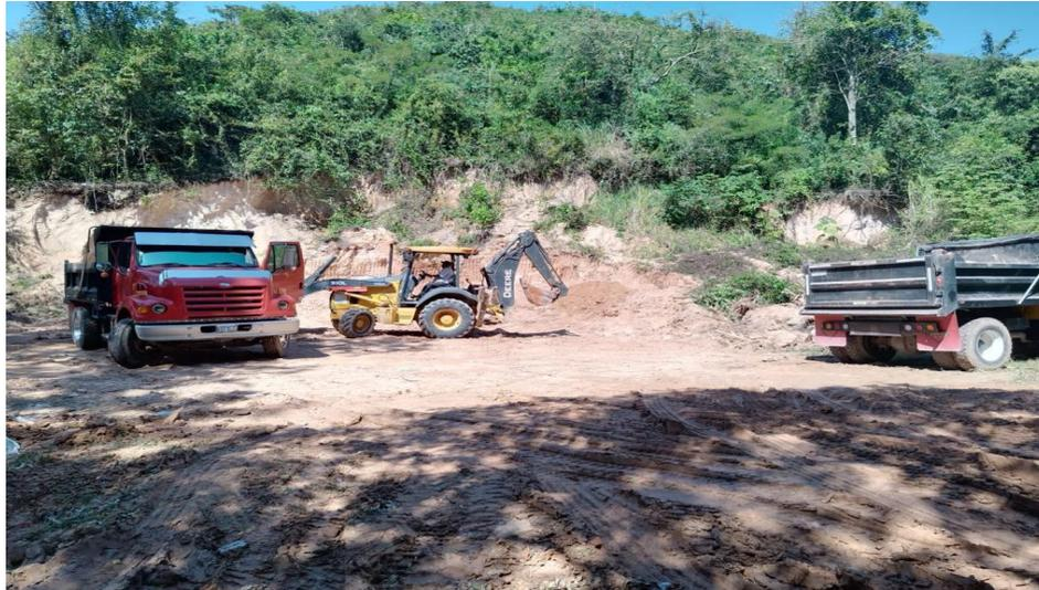
Máquina Retroexcavadora 310-L en carga de material selecto para soterramiento de basura en Relleno Sanitario
