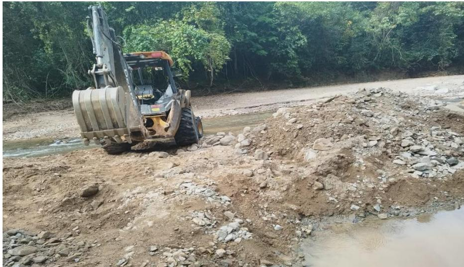
Máquina Retroexcavadora 310-L en trabajos de zanjeo para posteriormente construcción de gaviones en el río Chiquito
