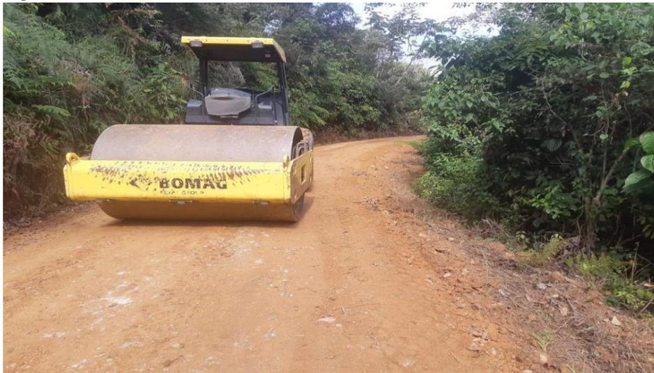
Trabajos de escarificado, conformación, cuneteo y vibrado de calles en la aldea Agua Buena
