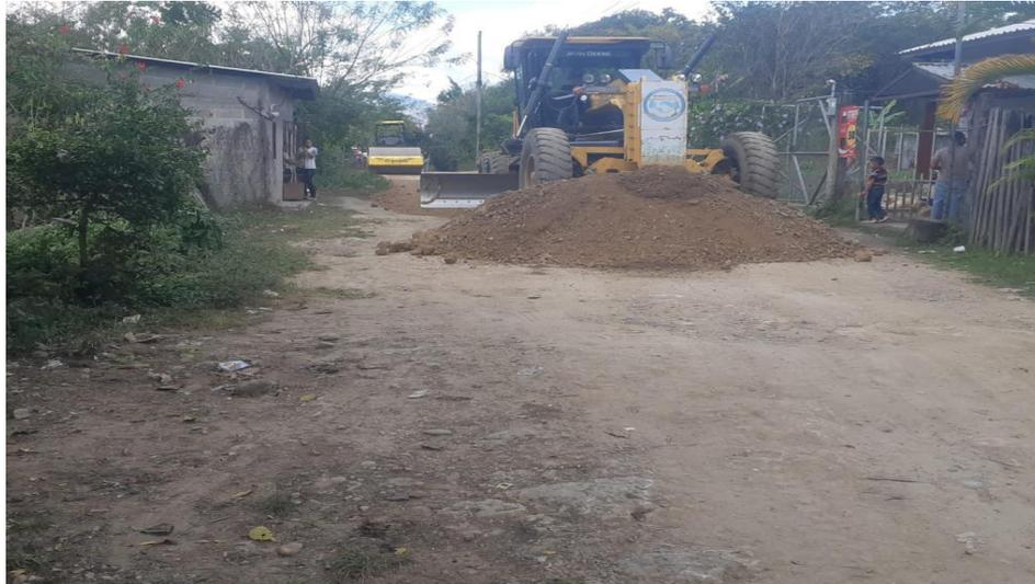
Trabajos de escarificado, conformación, cuneteo y vibrado de calles en la aldea El Tablón.
