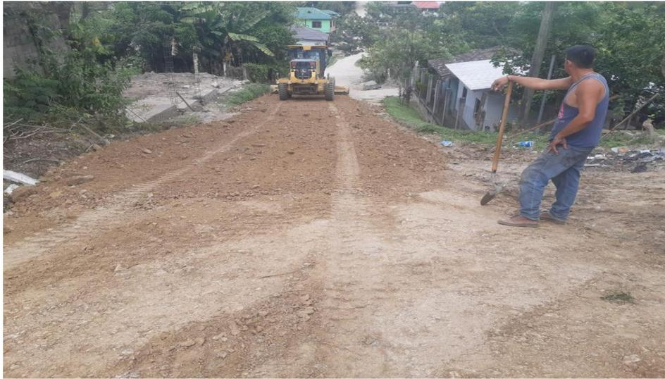
Maquina Motoniveladora 670-G y Vibro compactador en trabajos de escarificado, conformación, cuneteo y vibrado de calles en la aldea Nueva Arcadia
