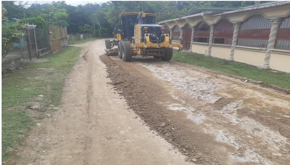
Trabajos de escarificado, conformación, cuneteo y vibrado de calles en la aldea La Colmena
