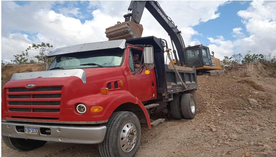
Excavadora 210-G en trabajos de corte y carga de material selecto para balastar calles de la aldea Nueva Arcadia, el material se corta en la aldea El Llanón.
