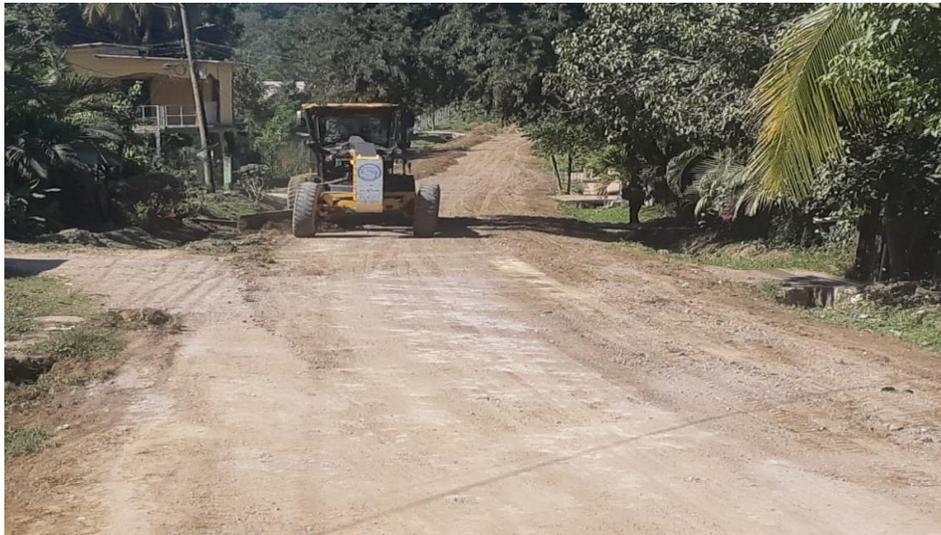
Maquina Motoniveladora 670-G y Vibro compactador en trabajos de escarificado, conformación, cuneteo y vibrado de calles en la aldea Los Tangos.
