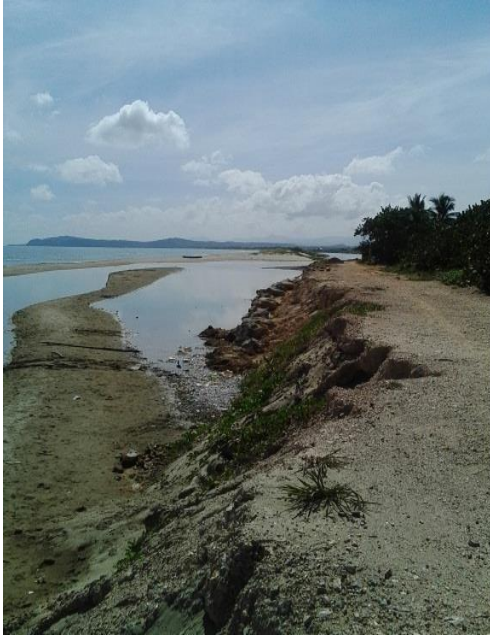
Rio Salado desmorona la borda de contencion en la comunidad de Limon
