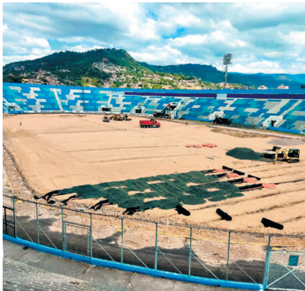
Una de las grandes obras que realiza esta administración es la modernización de la cancha del Estadio Nacional Chelato Uclés en Tegucigalpa.
