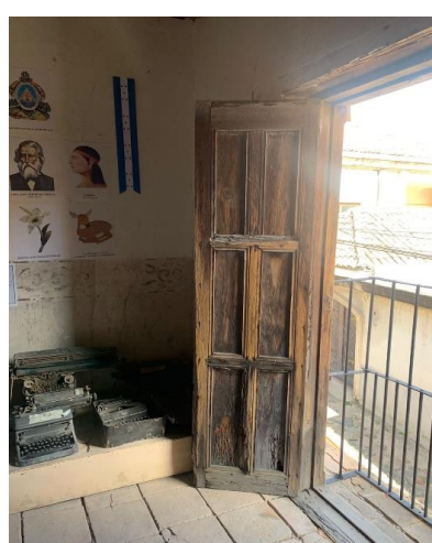
Foto 9: Puertas en condiciones totalmente
