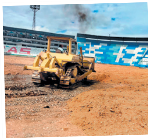
Ya se están dando los primeros pasos para que en 2023 arranque la modernización del Estadio Morazán de San Pedro Sula.
