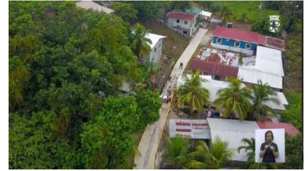
Reparacion de calle de la gran villa
