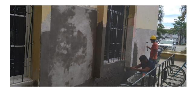
COLOCANDO IMPERMEABILIZANTE EN PAREDES DEL LABORATORIO DEL DEPARTAMENTO AMBIENTAL.
