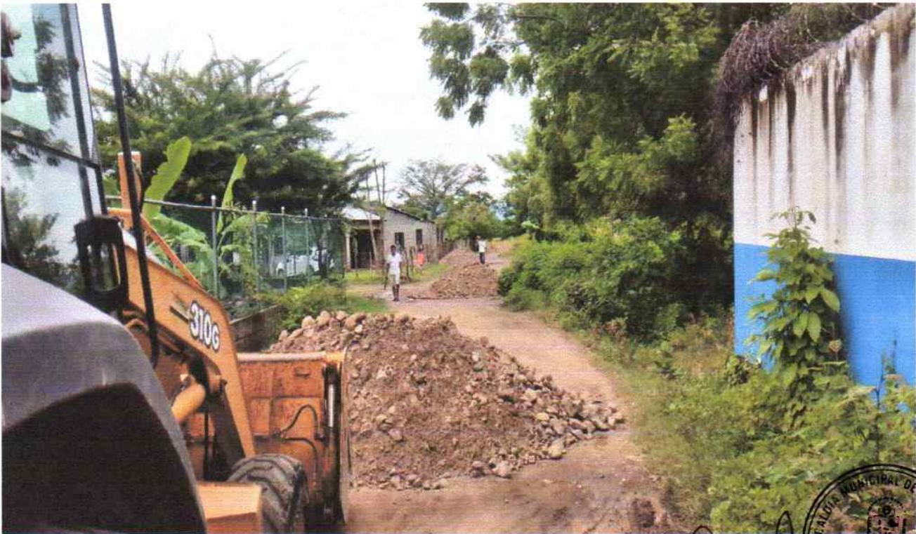
Foto 6. Retroexcavadora regando material, Namasigüe, Choluteca.
