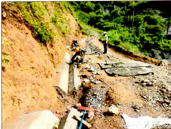
Ilustración 2: Trabajos de construcción de cuneta enchapada en "V"
