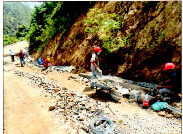
Ilustración 2: Trabajos de construcción de cuneta enchapada en "V"
