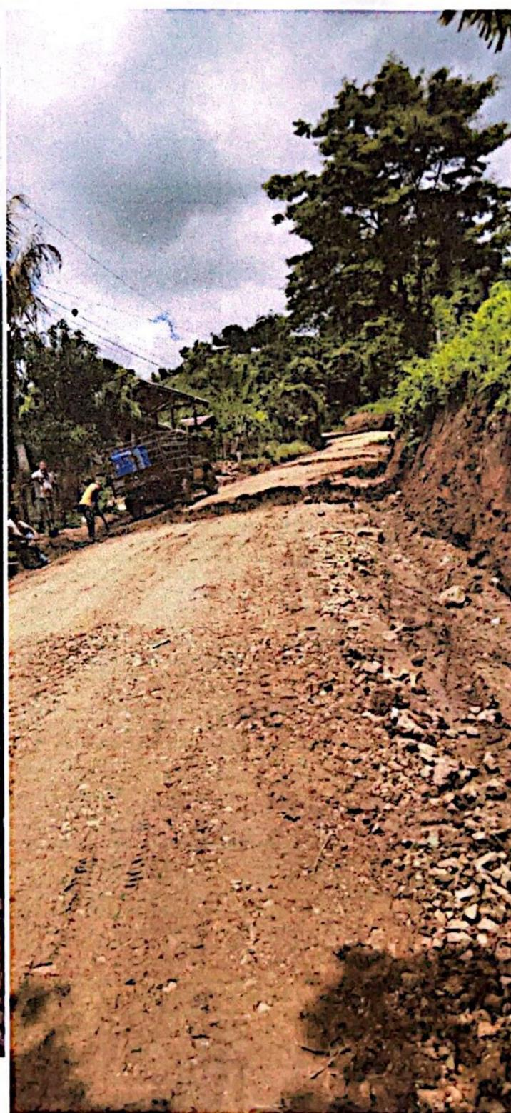
servicios de mantenimiento de Uno punto noventa y uno (2.23km) de calle, incluye conformación tipo ii (motoniveladora, vibro compactador y tanque cisterna), suministro, corte, carga y acarreo de material selecto desde banco de préstamo ubicado en la comunidad del destino de este municipio. Se comenzó con la reparación de la calle principal de Las Quebraditas
