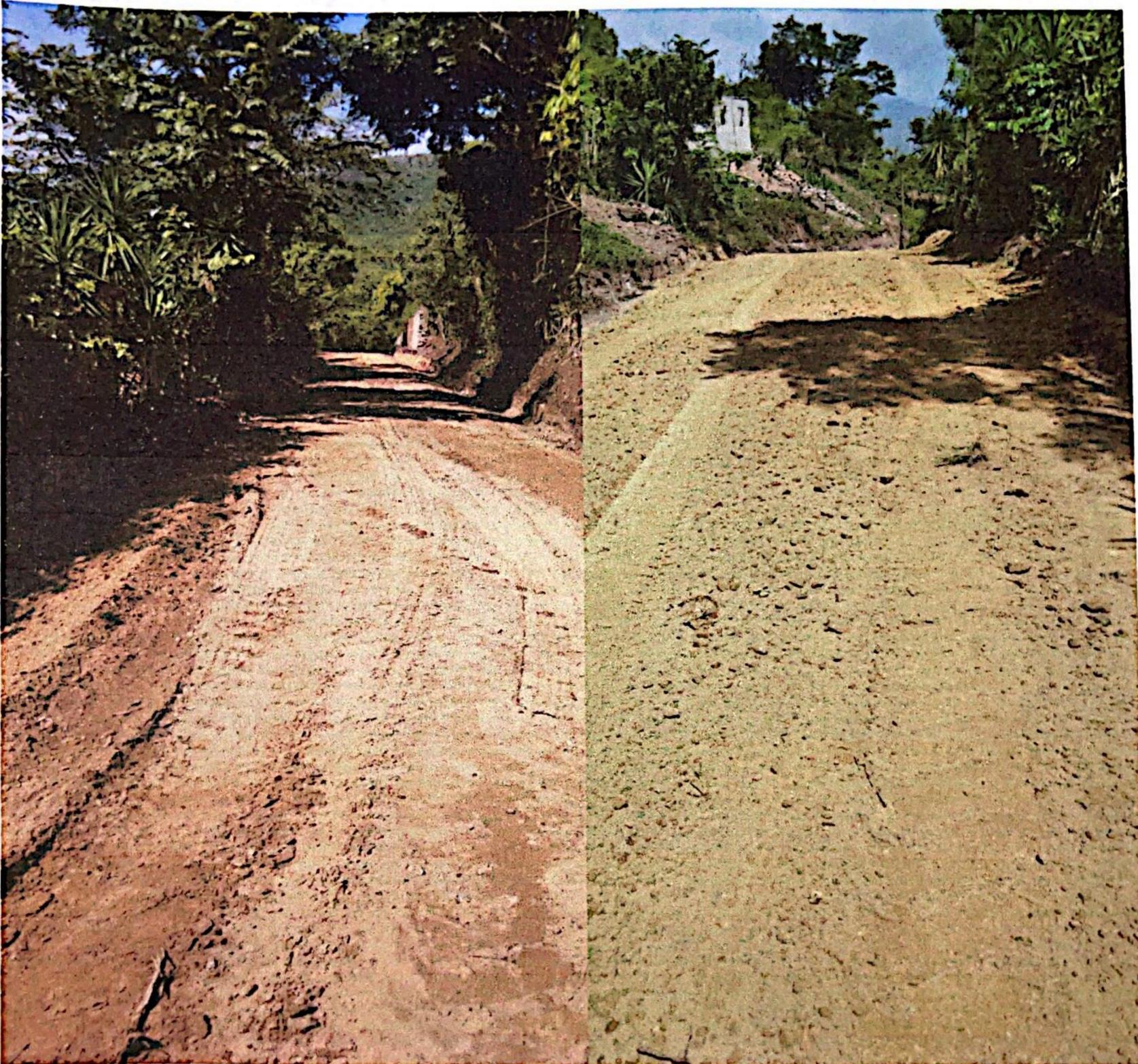
servicios de mantenimiento de uno punto cinco (1.5 km) de calle, incluye conformación tipo ii (motoniveladora, vibro compactador y tanque cisterna), suministro, corte, carga y acarreo
