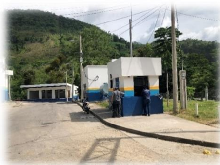
Ilustración.13: Casetas de control
