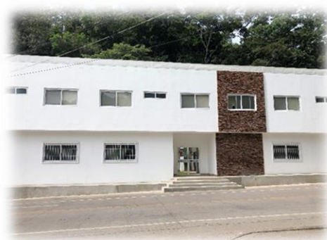
Ilustración.11: Complejo habitacional Puesto Fronterizo Integrado El Florido.
