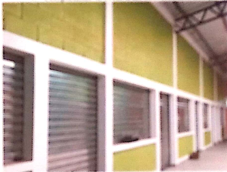
4. Completando la oficina 4 con 100% de su interior
