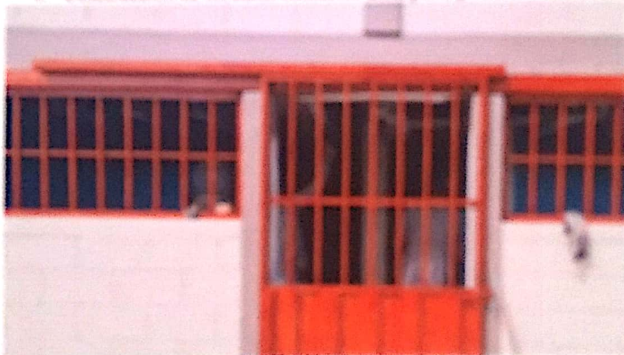
1. Construcción de módulos sanitarios en la parte posterior del edificio
