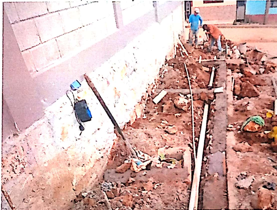
Excavación, cimentación y colado de concreto en aceras
