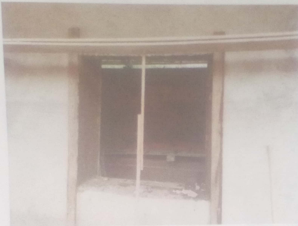
Figure 3 Ampliación de ventanas
