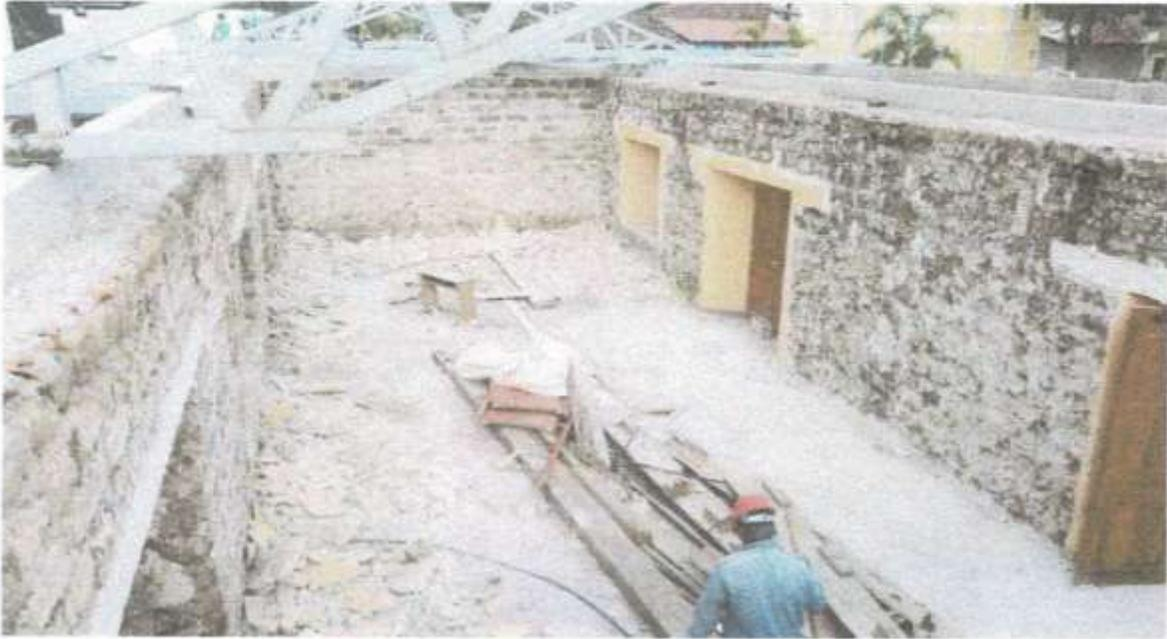
*Ilustración 1 DEMOLICION DE REPELO Y PULIDO*
