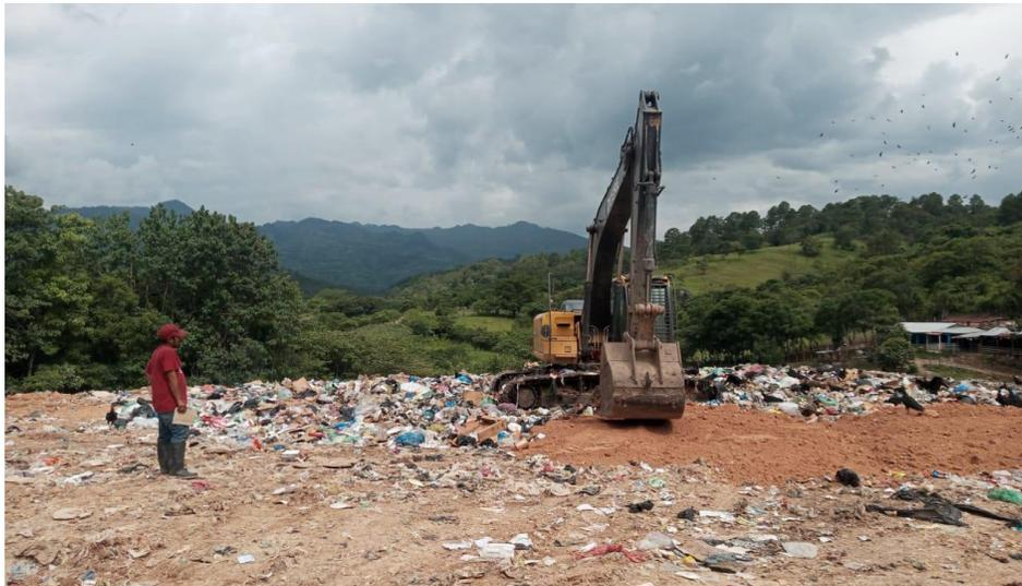
Se aprecia la maquina municipal Excavadora 210-G en trabajos de soterramiento de basura en Relleno Sanitario Barrio Bella Vista 2
