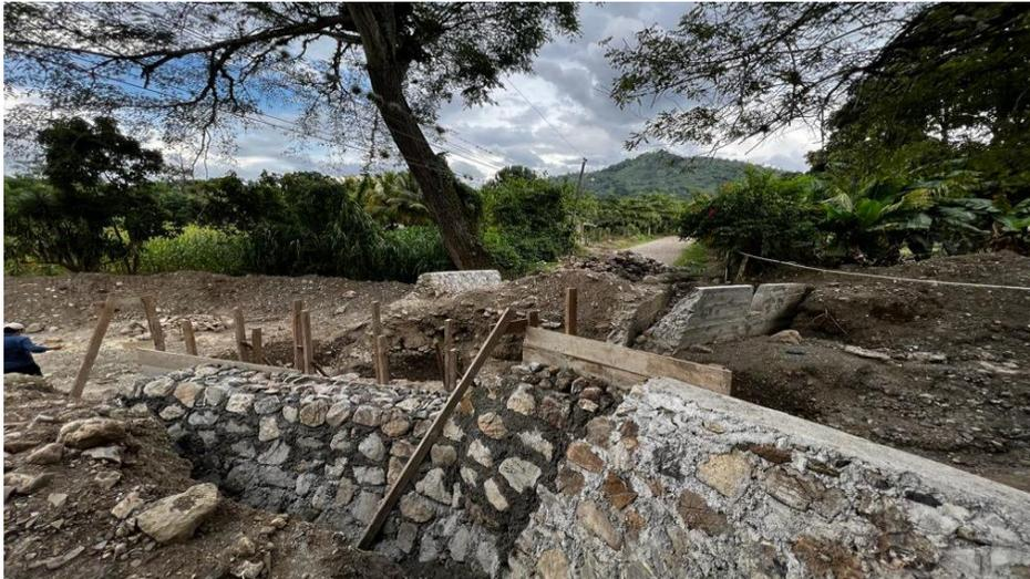
Se aprecia la construcción de las alas en el proyecto Construcción de caja puente a 1,000 metros de puente hacia Aldea Quebrada Seca.
