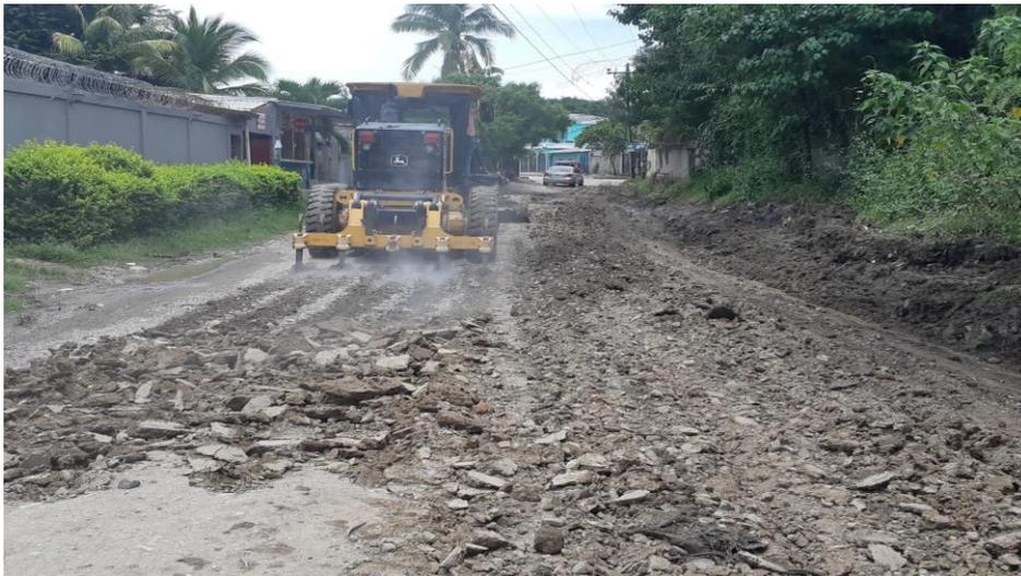
Maquinaria municipal en trabajos de escarificado, conformación, cuneteo y vibrado de calle que conduce del Barrio El Dorado hacia Aldea Santa Luz
