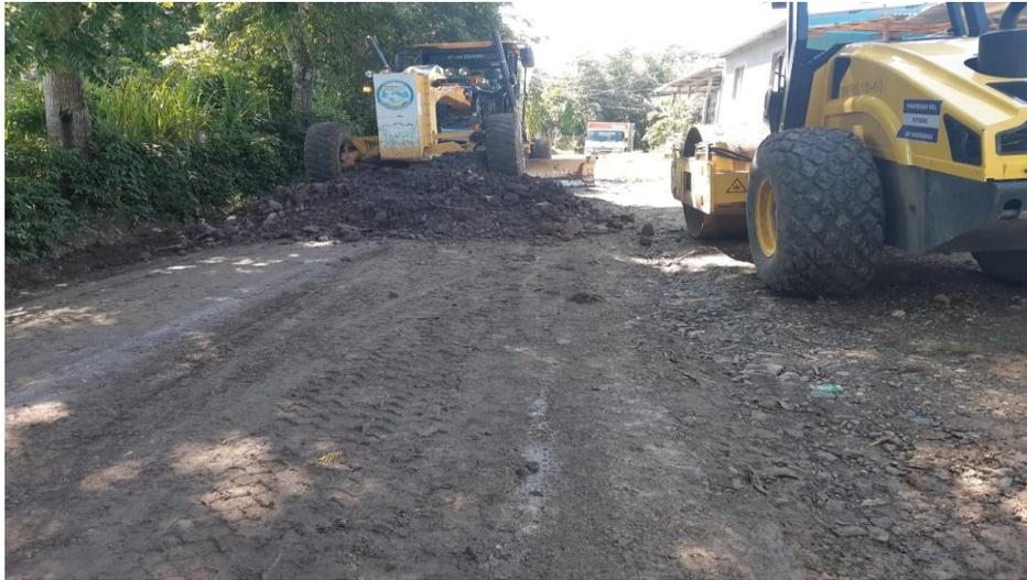
Maquinaria municipal en trabajos de escarificado, conformación, cuneteo y vibrado de calles Barrio Suyapa
