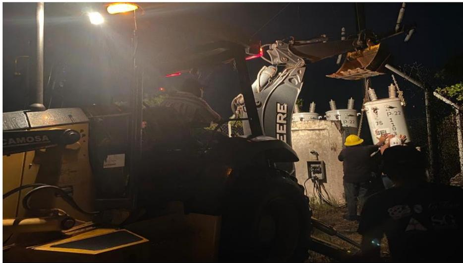
Se aprecia la maquina Retroexcavadora 310-L en trabajos de apoyo para la instalación de un transformador en el banco de transformadores del sistema de bombe en río Chamelecón
