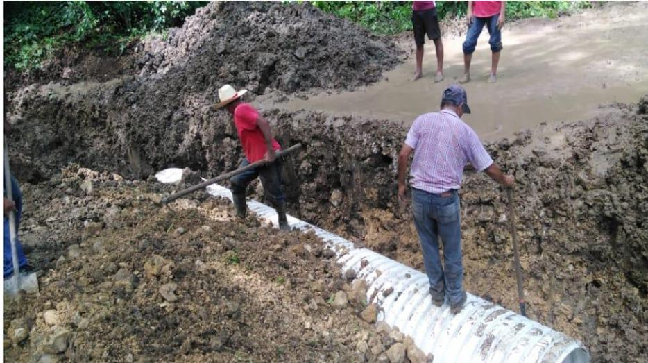
En la imagen superior se aprecia la instalación de una alcantarilla de 36 pulgadas y en la imagen inferior se visualiza la instalación de una alcantarilla con un diámetro de 24 pulgadas
