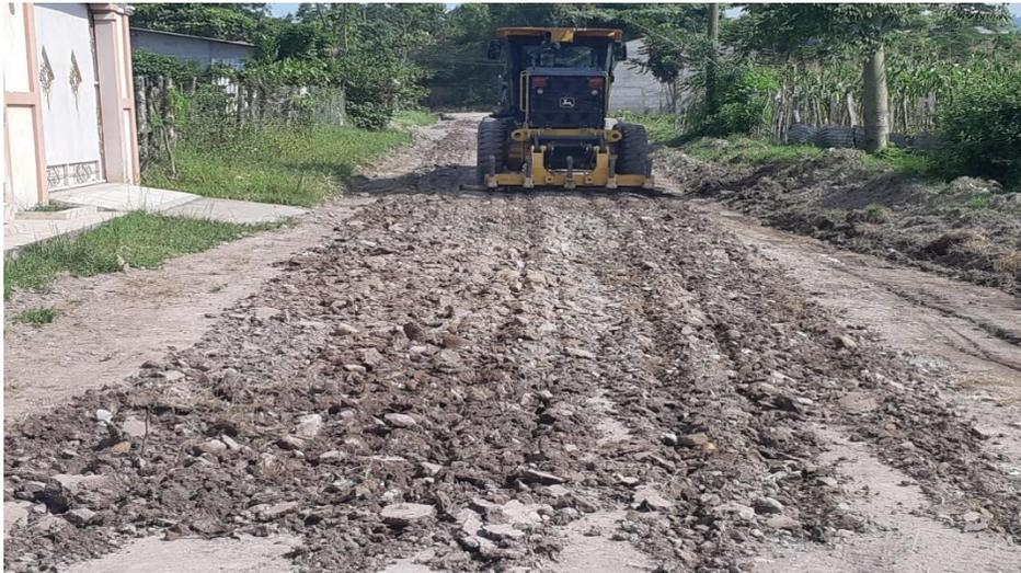
Se aprecia a la maquina Municipal Motoniveladora 670-G y Vibro compactador en trabajos de escarificado, conformación, cuneteo y vibrado de calles en la Colonia Nuevo Amanecer.
