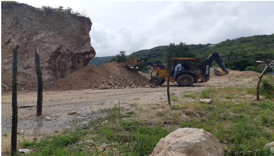
Se visualiza la maquina municipal Retroexcavadora 310-L en trabajos de corte y carga de material selecto para soterramiento de basura en Relleno Sanitario Barrio Bella Vista
