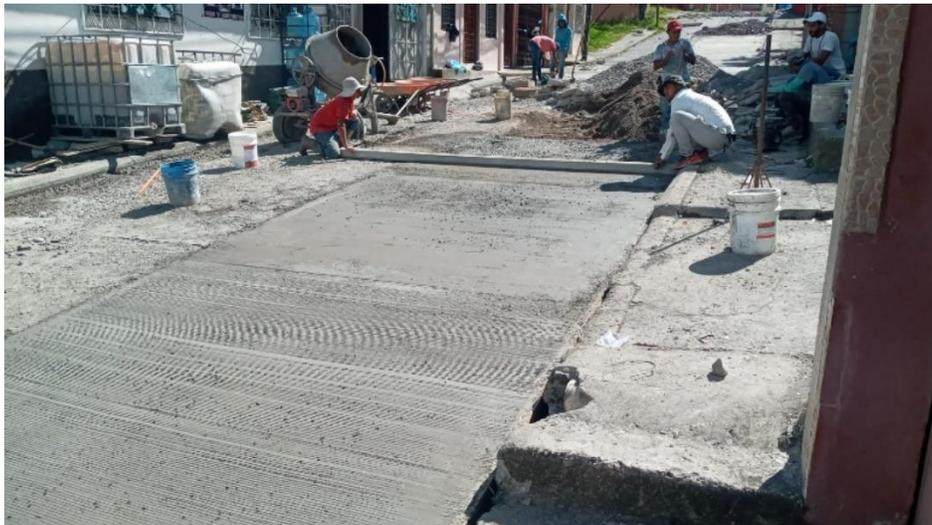
Se aprecia la fundición de losa de concreto hidráulico en el proyecto Mantenimiento y reconstrucción de calle que conduce de la CA-4 hacia el Instituto Bernardo Galindo y Galindo, Barrio Miraflores Sector 5
