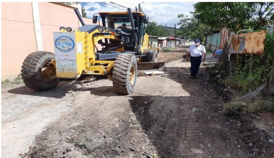
Maquina Motoniveladora 670-G y Vibro compactador en trabajos de escarificado, conformación, cuneteo y vibrado de calles en Barrio El Dorado
