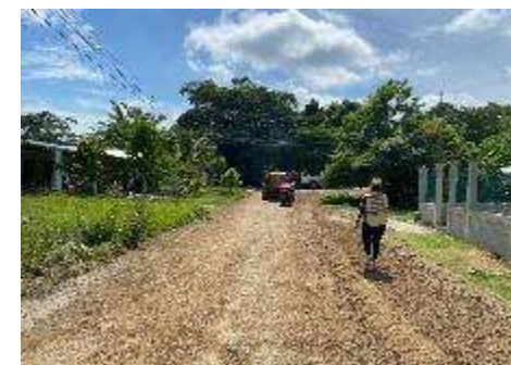
Apoyo al Depto. De Mantenimiento Vial En la reparación de calles y callejones de Bo. Palermo, Sector El Porvenir.
