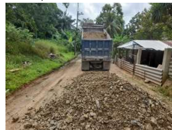
Apoyo al Depto. De Mantenimiento Vial en la reparación de calle de la Comunidad de la Concordia, Sector El Chile.
