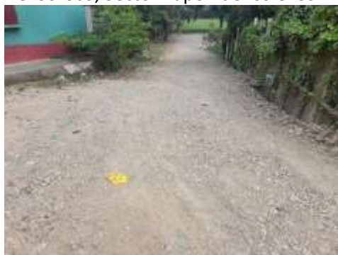
Apoyo al Depto. De Mantenimiento Vial En la Reparación de Calle de la Comunidad Del Sofoco, Sector Tapon de los Oros
