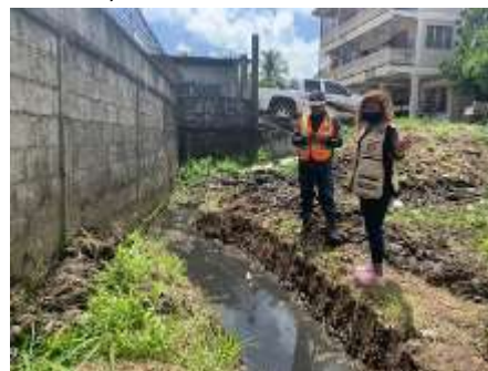
Apoyo al Depto de Servicios Públicos en El dragado y limpieza de quebrada de Bo. Palermo, Sector El Porvenir.
