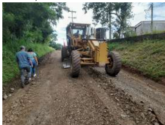
Apoyo al Depto. De Mantenimiento Vial en la reparación de calle de la Comunidad de Mega Concordia, Sector El Chile.
