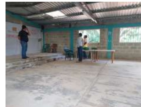
Evaluacion del Centro Social de la Comunidad de Brisas de Chameleconcito Sector Chameleconcito.
