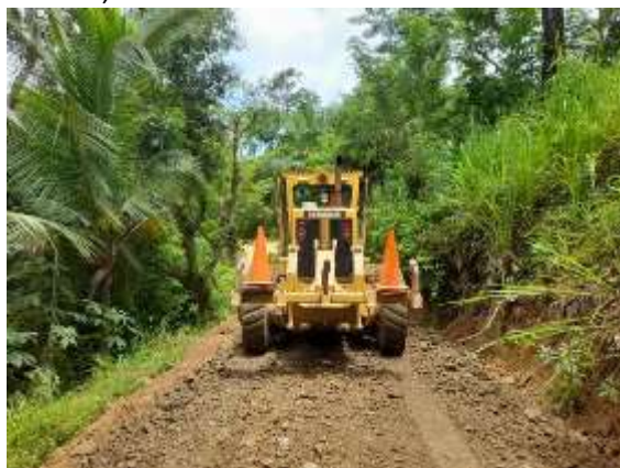
Apoyo al Depto. De Mantenimiento Vial en el Mantenimiento de calle de la Comunidad de El Chile, Sector El Chile.
