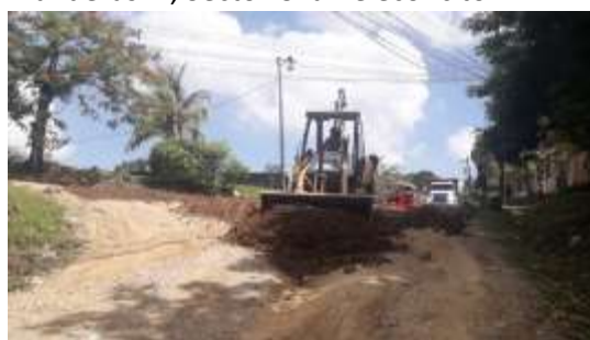
Apoyo al Depto. De Mantenimiento Vial en la reparación de calle en la Comunidad de Banderas III, Sector Chameleconcito.
