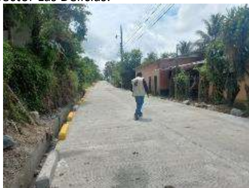
Inspeccion del proyecto de pavimentacion De calle de la Comunidad de Bully Champa, Sector Las Delicias.
