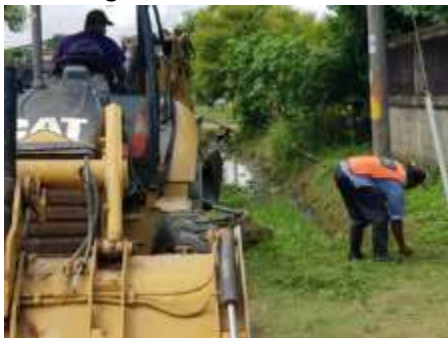
Apoyo al Depto. De Servicios Públicos en la Limpieza de Canales Pluviales de Bo. Los Mangos, Sector Peninsula Oeste 2.
