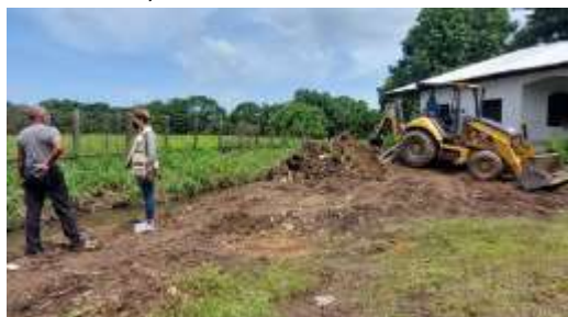
Apoyo al Depto. De Servicios Públicos en la Limpieza y dragado del canal pluvial de Bo. El Porvenir, Sector El Porvenir
