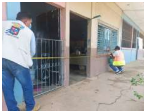
Evaluacion del techado de la Esc. Zacarías Álvaro Mena de la Comunidad de Banderas III, Sector Chameleconcito.
