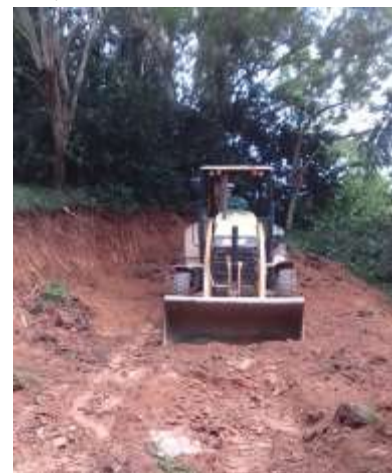
Apoyo al Depto. De Mantenimiento Vial en la reparación de calle de la Comunidad De la Presa, Sector Ecoturistico.
