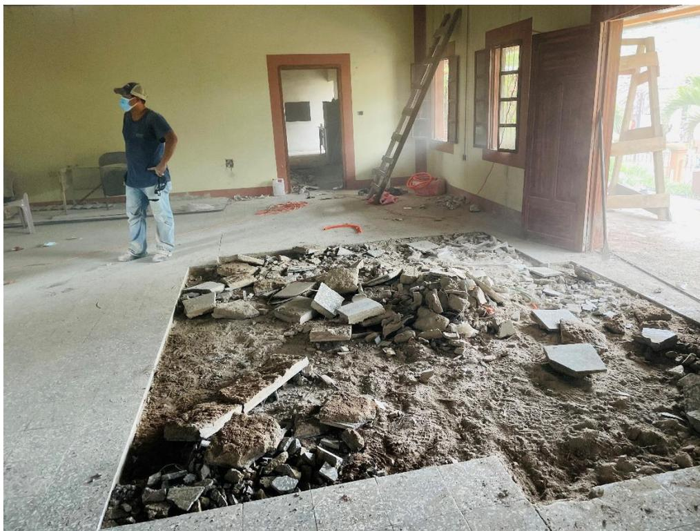
Demolición de piso de mosaico dañado, para posteriormente remodelarlo.
