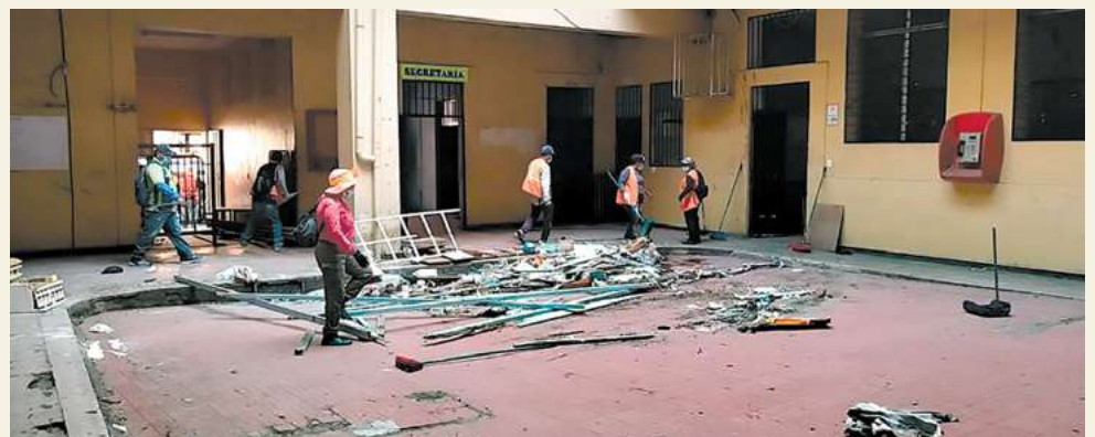
Los centros educativos que sufrieron daños por la temporada ciclónica ya están siendo reconstruidos por el equipo de construcciones escolares de la Secretaría de Educación.
