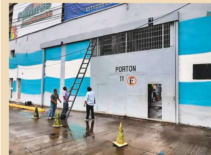
Parte de la fachada del estadio “Chelato Uclés”, donde se observa a los trabajadores arreglando el portón 11.
