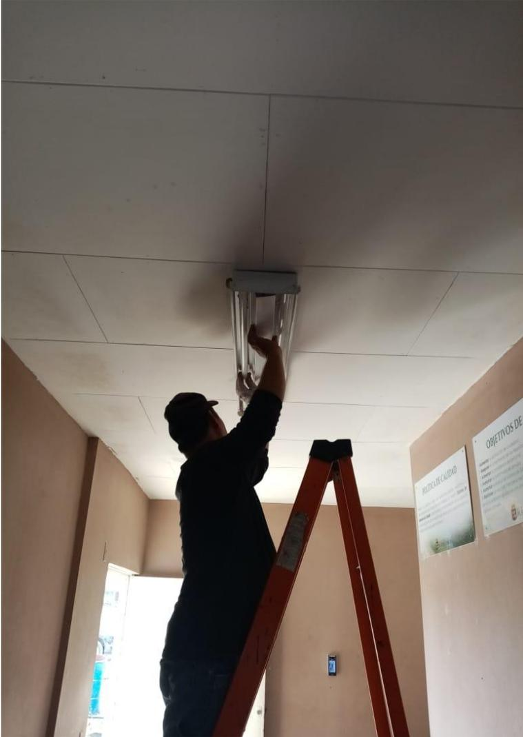
*Ilustración 1-Cambio de lámparas en mal estado en Oficinas de Mantenimiento Vial-*
