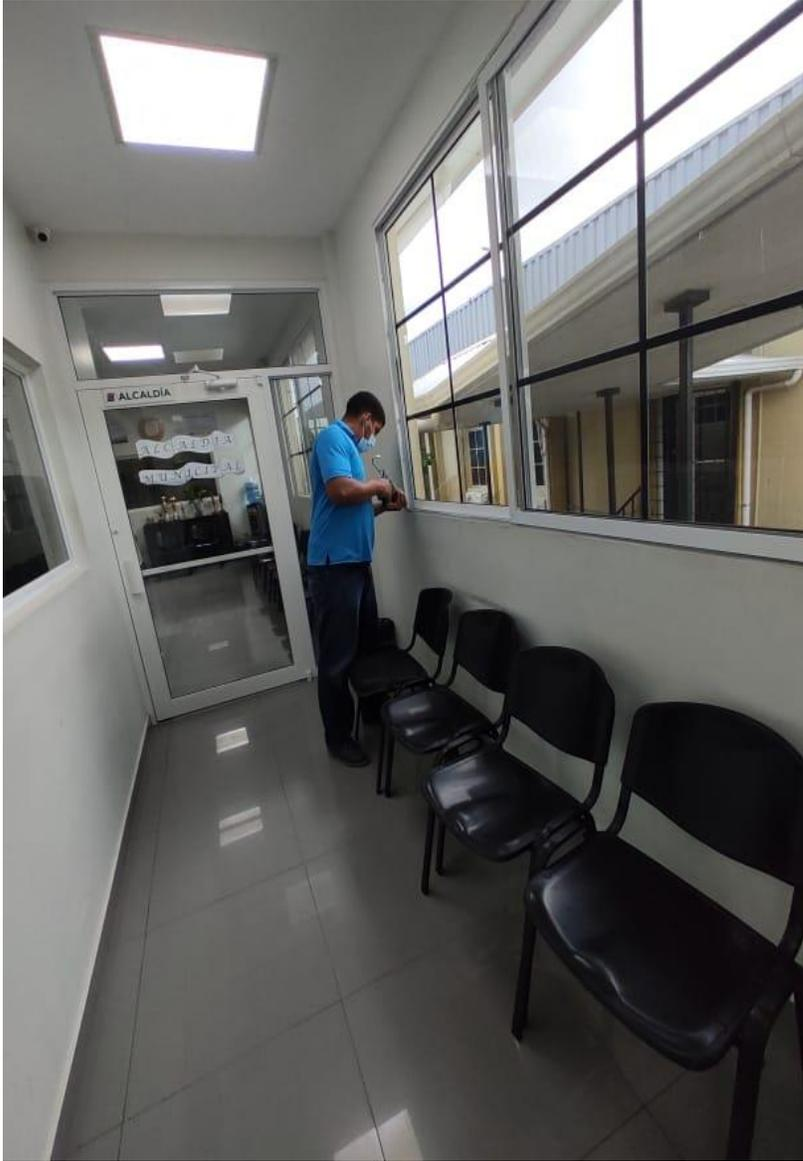
*Colocación de Silicon alrededor de Ventanales para evitar filtración de agua durante temporada de lluvia.*
