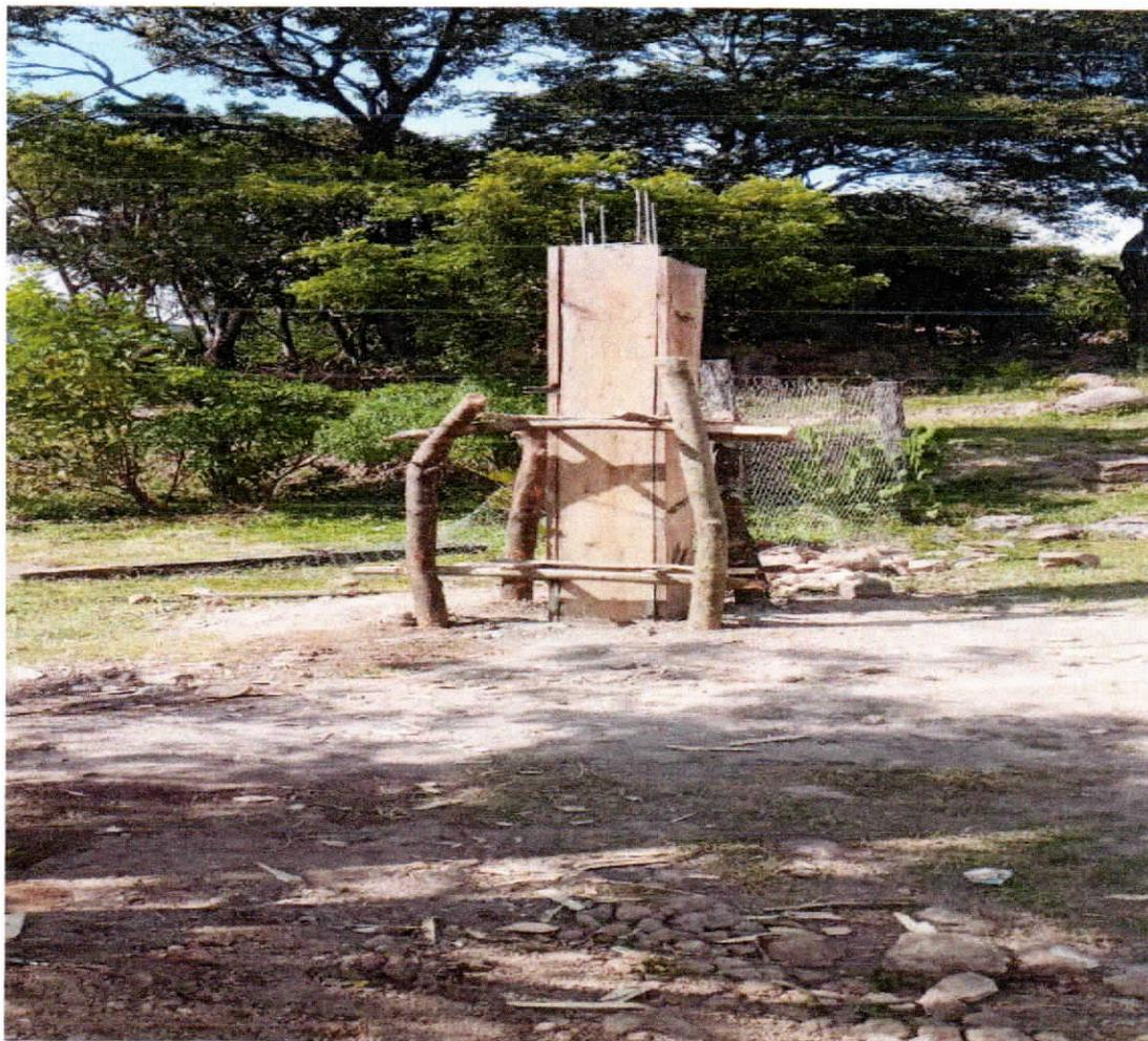
Se paso al siguiente paso, desencofrar las columnas para permitir continuar con las siguientes actividades.
