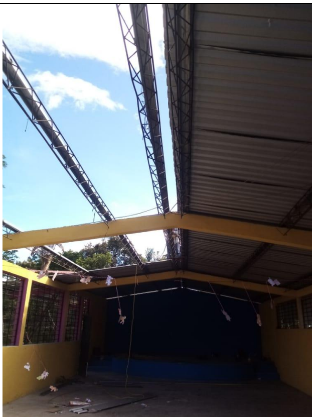
Instalación de canaleta para reforzar la estructura.
