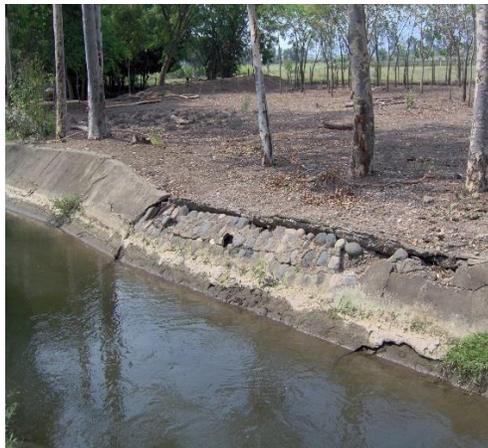
Enchape de Fondo y Mampostería: Se sustituciones de talud y fondo del canal, enchape de mampostería,
