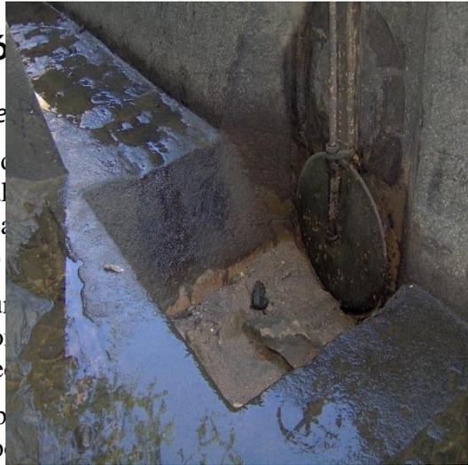
Imagen 12. Compuerta del desagüe en canal de derivación
