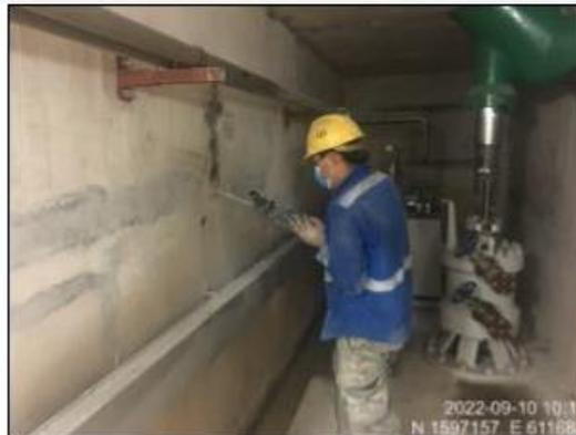
Perforación en paredes con presencia de humedad en Galería de Casa de Máquinas.
