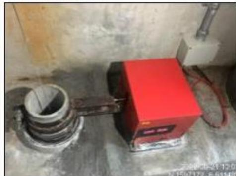
Fundición de protección para evitar filtración en caja de Péndulo invertido dentro de Galería de Cuerpo de Presa.
