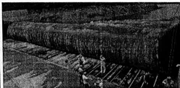
Cortina inflada, vista desde el exterior de la represa
