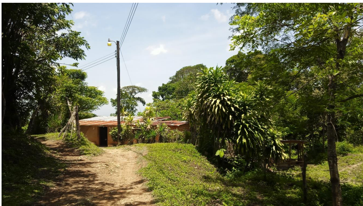
Punto 23 x=380970.3 y=1639273.60. Poste podrido en la base.
