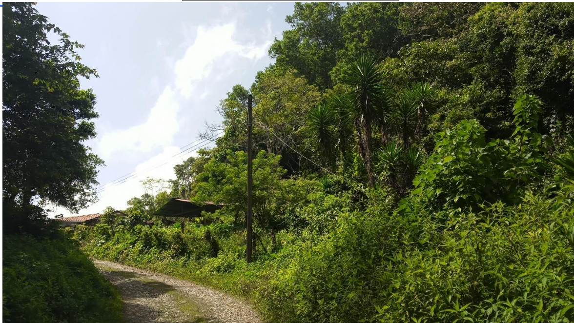
Imagen de Punto 2 x=380683.8 y=1639978.7 presenta daño en la base, cuenta con madera carcomida por hongos de humedad.
