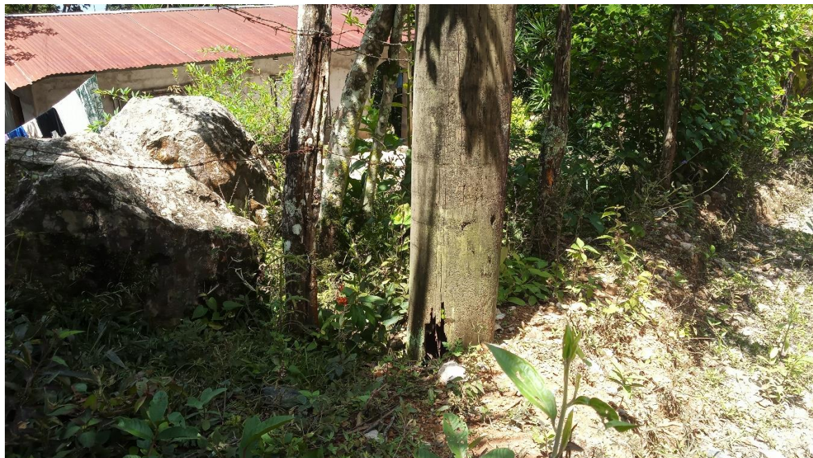
Imagen del punto 4. Poste podrido en la base.
