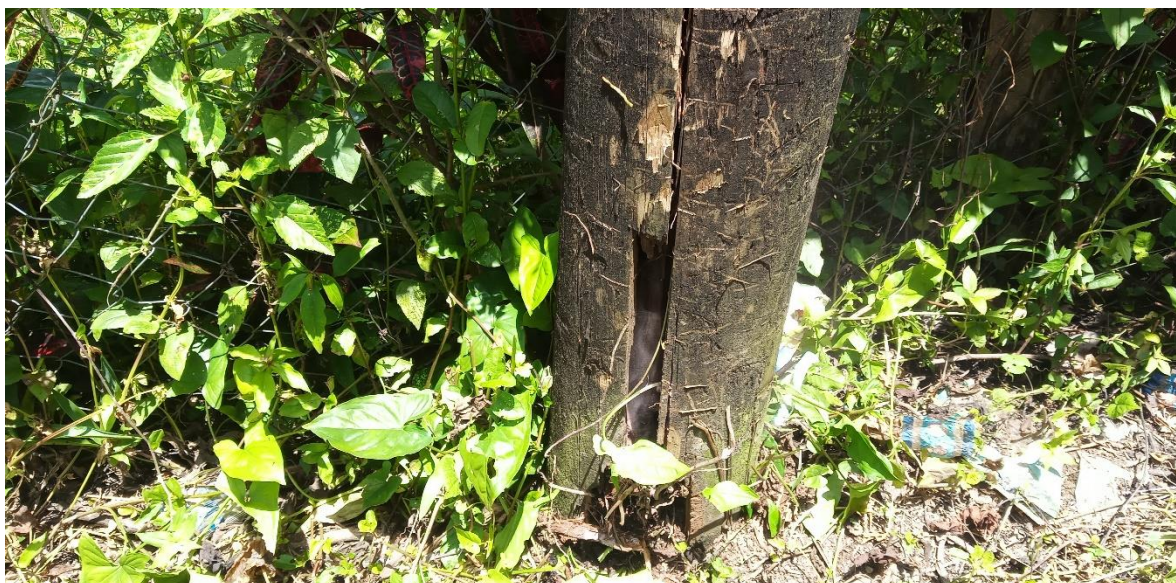
Imagen de poste punto 24
