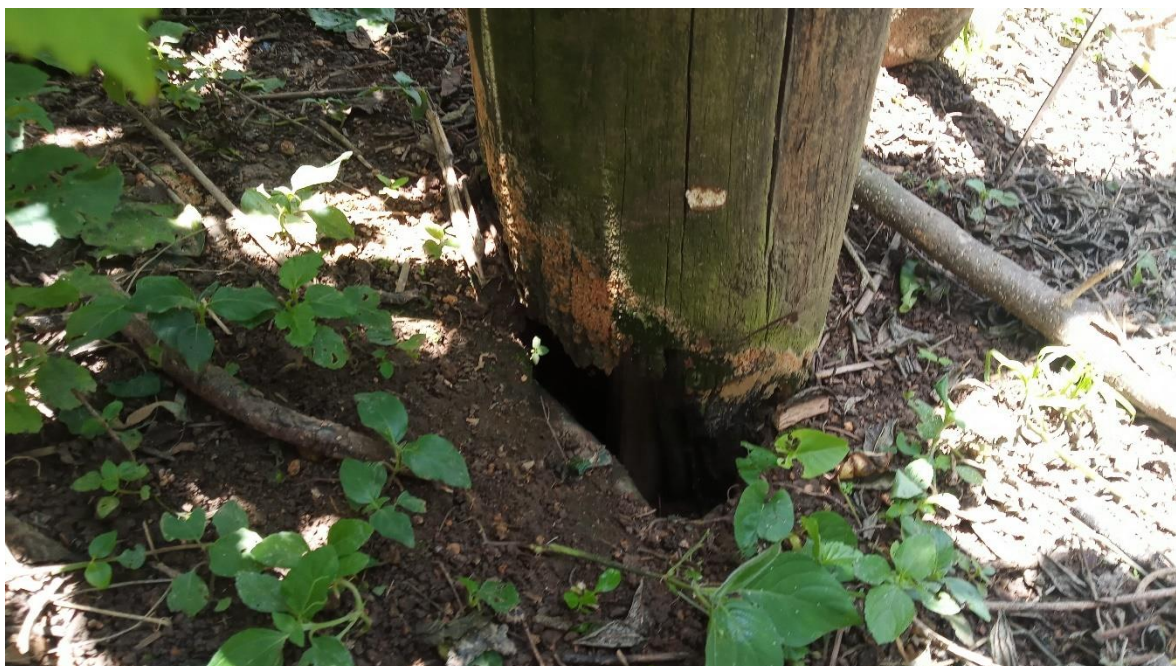
Punto 28 x=381110.40 y=1639196.10 Poste dañado en la base.
