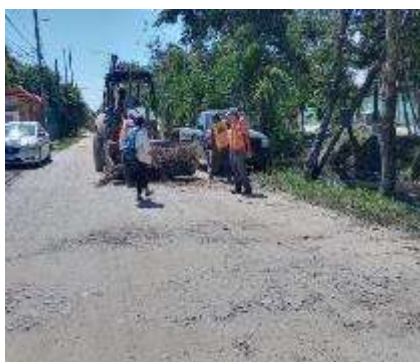
Limpieza de Macro Canal de Bo. El Centro Sector Península Este 2
