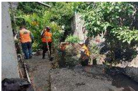
Mantenimiento de cuneta del callejón Monte Carlo de Bo. El Porvenir Sector El Porvenir.
