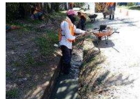
Limpieza de las alcantarillas pluviales de Bo. San Martín, Sector Península Este 2.
