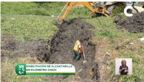
Habilitación de alcantarilla en kilómetro cinco
