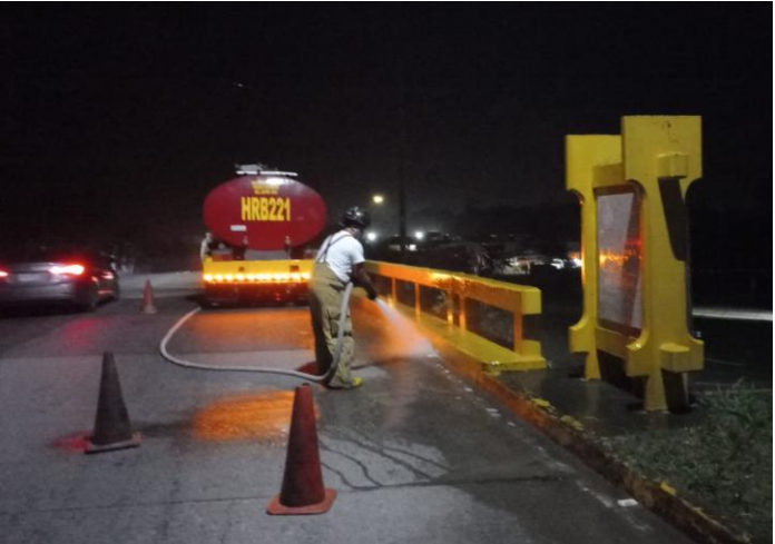
Lavado de puente y medianas
